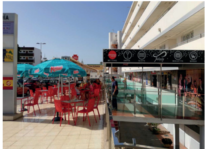
Fig. 1-35: Bajos comerciales a nivel de la calle y por debajo en foso, se requiere pasarelas y escaleras de conexión. Avenida de Tirajana. Fuente: O. de Castro
