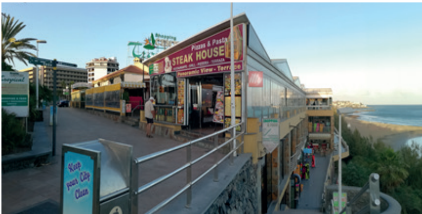
Fig. 1-14: Centro comercial Tropical, vista desde el paseo marítimo.
