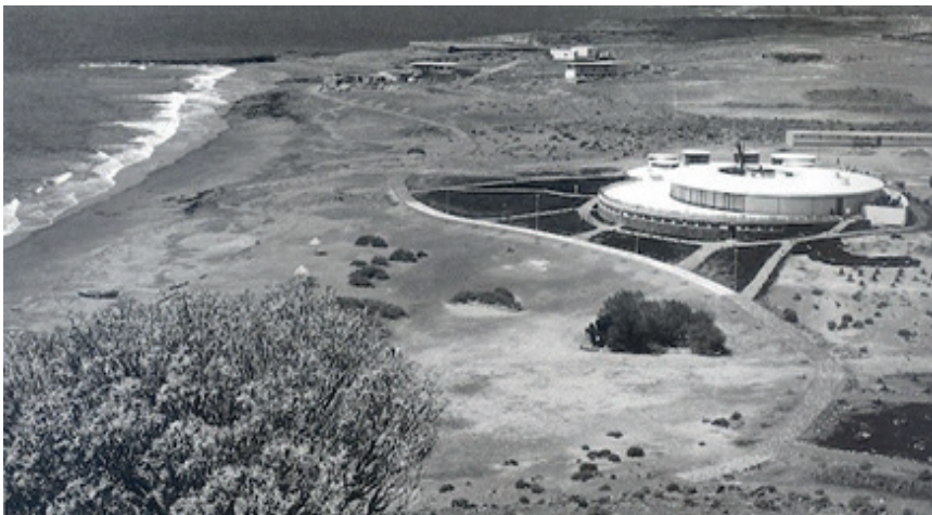
Fig. 0-6: “Las Rotondas” en San Agustín (Maspalomas-Costa Canaria), década 1960. Arquitecto Manuel de la Peña. Equipamiento con usos de balneario, restaurante y comercios. Demolido en la actualidad
