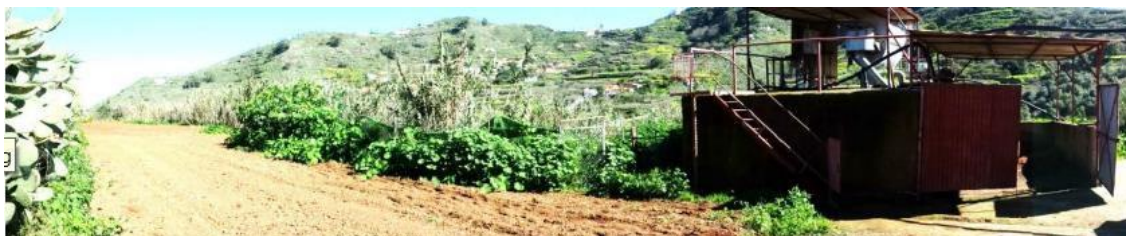
Ilustración 2. Panorámica general planta piloto SDN.
