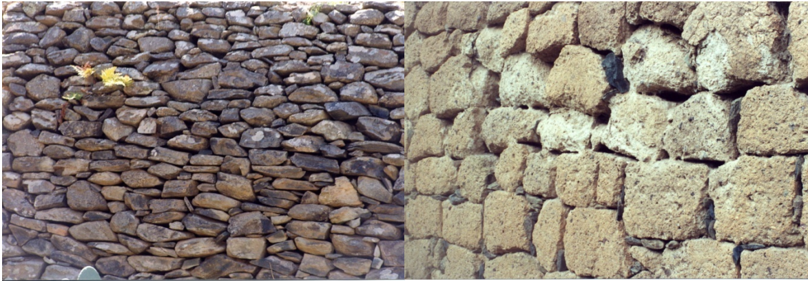
Figura VII.6b. Tipos de mampostería en las unidades de bancales. Mampostería de rajuela (izquierda) y en hilera (derecha).
