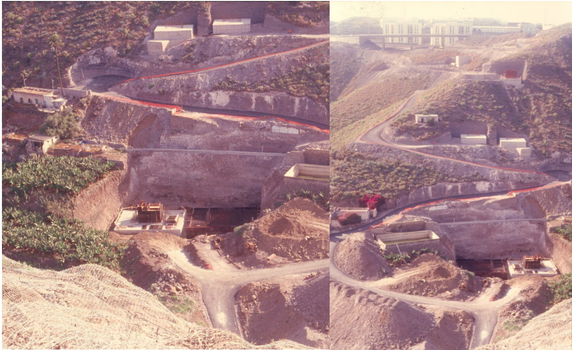
Figura VII.10. Construcción de los pilares del viaducto del Guinguada en bancales 1999 (Unidad nº25, Albiturria. Cauce bajo del Guinguada).
