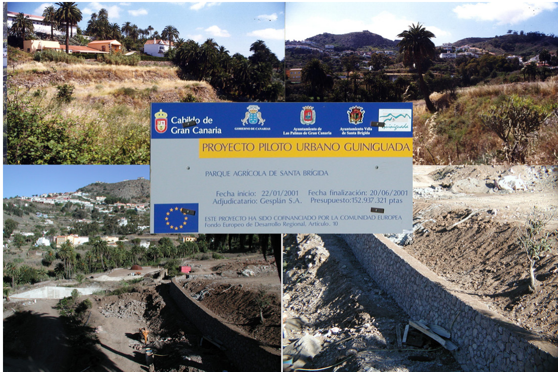
Figura VII.43. Unidad 103 (Finca El Galeón) antes y durante la ejecución de las obras de acondicionamiento del Parque Agrícola de Santa Brígida.
