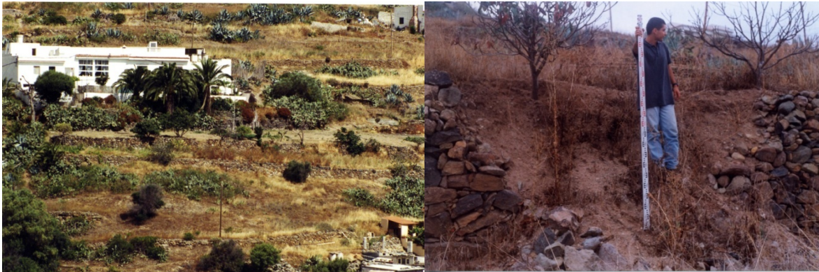
Figura VII.32. Unidad nº71 (Andújar) (izquierda) y desprendimiento en campo nº2 (derecha).
