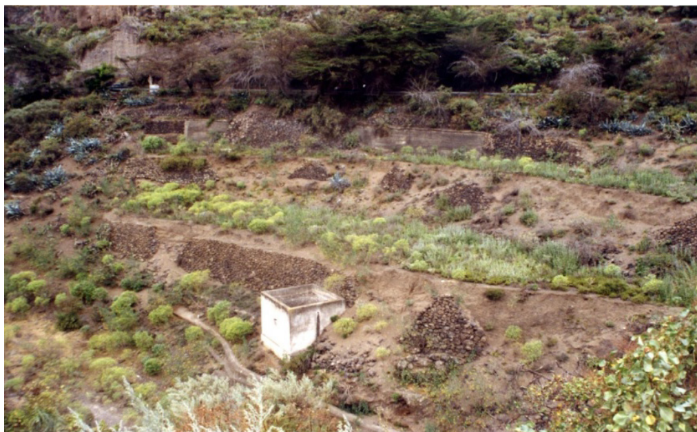
Figura VII.35. Unidad de alta prioridad para la restauración (nº49, Puente de la Angostura).
