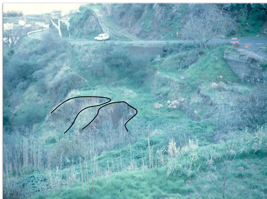
Figura VI.22. Deslizamientos rotacionales (golpes de cuchara) en vertiente cóncava. Las Lagunetas.
