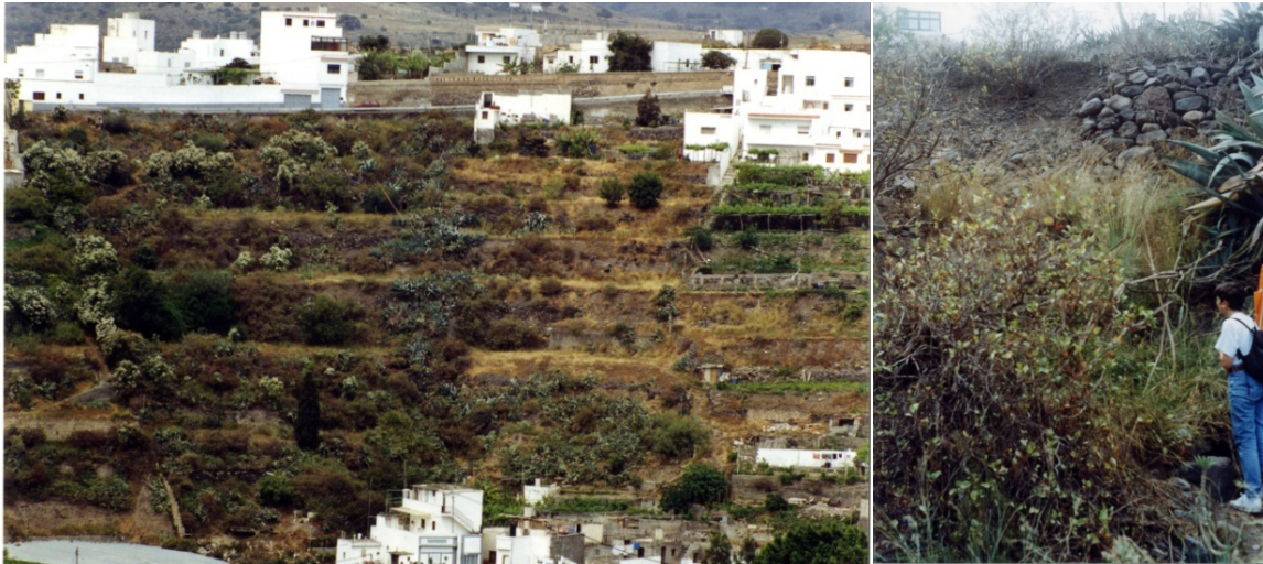
Figura VII. 30. Unidad de bancales nº40 (Dragonal Bajo) (izquierda) y detalles de desprendimiento en campo nº4 (derecha).
