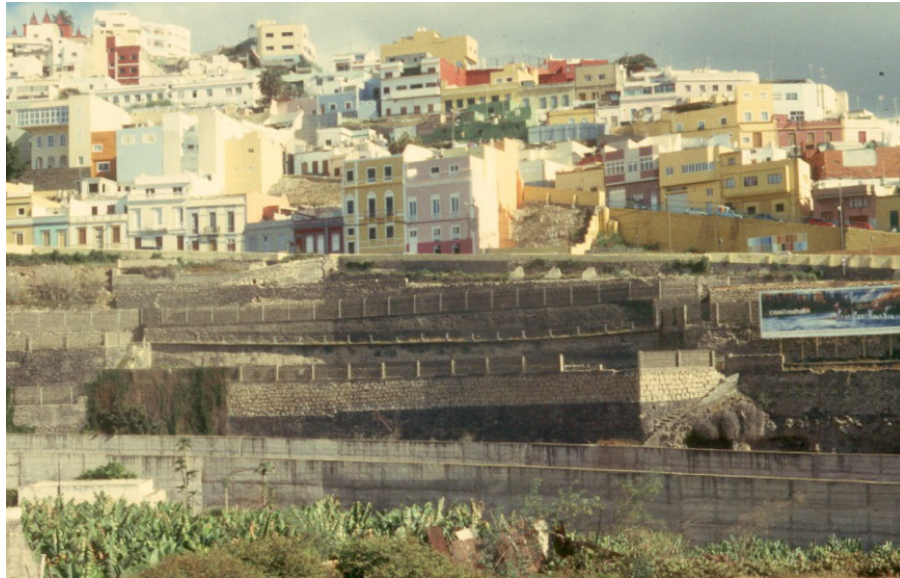
Figura VII.20. Unidad con moderada calidad para la conservación (nº 1, ladera de San Roque).
