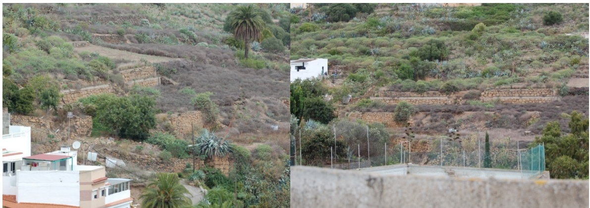
Figura VII. 25. Unidad con muy alta calidad para la conservación (nº51, Siete Puertas). Presenta mampostería en hileras de ignimbritas e importante recolonización vegetal.
