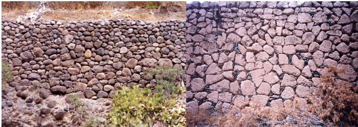
Figura VII.6 a. Tipos de mampostería en las unidades de bancales. Mampostería de cantos rodados (izquierda) y ordinaria (derecha).
