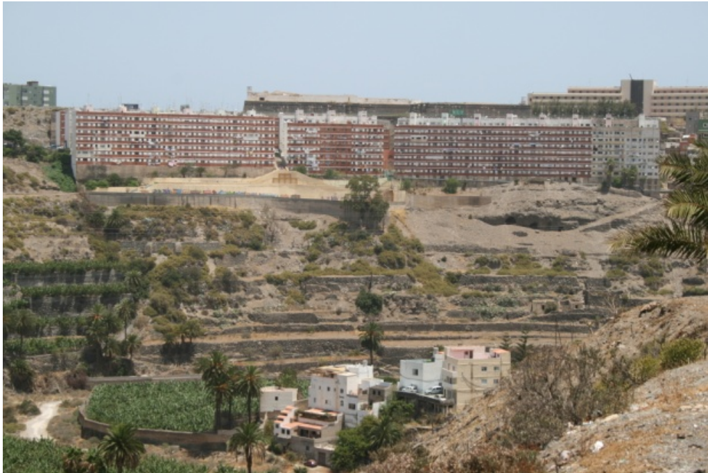
Figura VII.15. Unidad con muy baja calidad para su conservación (nº5, Ladera de San Francisco).
