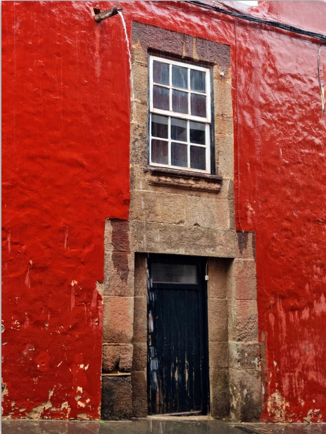
Fotografía 7.28: detalles de improntas muy marcadas de una tipología edificatoria externa de un pasado (de las casas que convivían con el Renacimiento castellano en la Isla de Gran Canaria). Estas improntas se encuentran en una casa que fue construida, posiblemente, a finales del siglo XVII, o a inicios del siglo XVIII, para un miembro destacado de la Inquisición (según la comunicación personal de doña Gema Ojeda Pérez, del 16 de febrero de 2023, a partir de su consulta al Cronista Oficial de Gáldar y profesor de universidad, don Juan Sebastián López García). Destaca la chorrera pétrea, aunque estrecha, entre la puerta principal y la ventana de la segunda altura. La imagen se tomó en un día de lluvias. Calle Santiago de los Caballeros, nº 3 (Gáldar, Isla de Gran Canaria). Captura del 9 de febrero de 2023.
