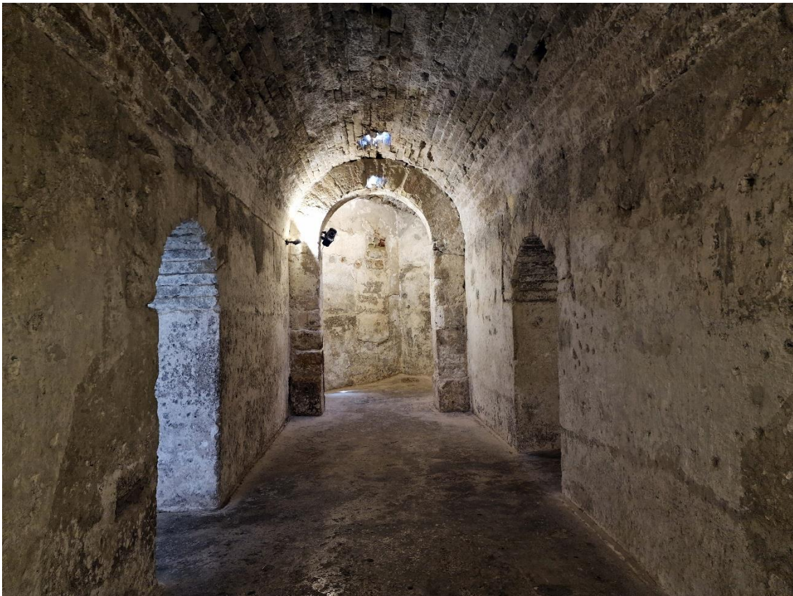
Fotografías 7.71 y 7.72: Aljibe Califal (siglo X), con dovelas, en la Alcazaba de Almería. Capturas del 20 de agosto de 2023.
