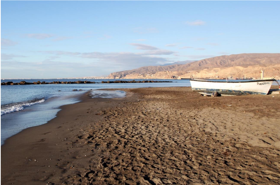
Fotografía 2.26: orilla oriental del semi tómbolo. La estabilidad, o la evolución, de la forma morfodinámica, en su conjunto, depende de las corrientes y transportes por gradientes de sobre elevación, del agua del mar, al difractarse las olas. La difracción del oleaje está originada por las singularidades dinámicas, que definen los extremos del dique exento (de la obra marítima, mar adentro, paralela a la orilla). Captura del 3 de diciembre de 2022.
