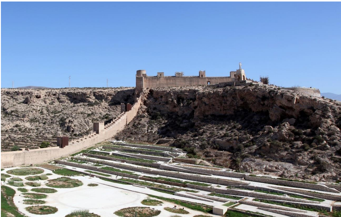
Fotografía 5.8: murallas musulmanas post fundacionales sobre el Cerro de San Cristóbal. Se observan torreones musulmanes (de planta cuadrada) y torreones de planta semicircular. Estos últimos fueron construidos por los Templarios, después de la primera conquista de la Ciudad por las tropas de Alfonso VII. La Ciudad estuvo en poder cristiano entre los años 1147 y 1157. Este Cerro es un globo panorámico de la Ciudad, y está acondicionado para esta funcionalidad. Captura del 20 de agosto de 2023.
