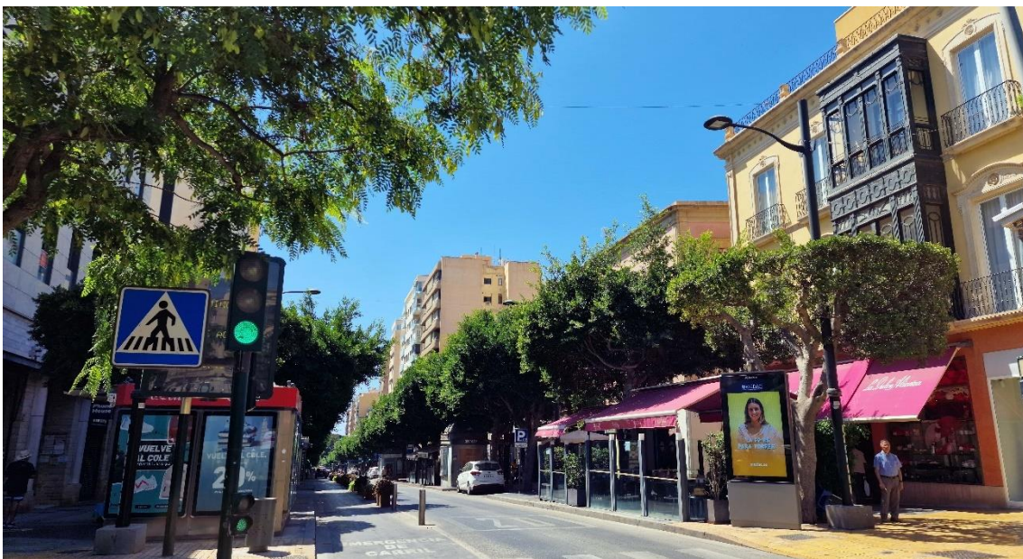
Fotografía 4.17: estampa actual de El Paseo, en un día de verano, cuando más apretaba el sol. Se aprecia la sustitución de edificios historicistas por otros posts racionalistas. Captura del 13 de agosto de 2023.
