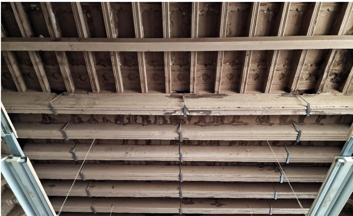
Fotografía 7.61: techo lignario de la Sala de Carpintería (Escuela de Arte y Superior de Diseño, Almería). La techumbre tiene dos diferentes escenarios mudéjares. Un escenario presenta jácenas, jaldetas y tablazones con taujeles (parte superior de la imagen) El otro escenario sólo contiene jácenas y tablazones (parte inferior de la imagen). Captura del 1 de diciembre de 2023.
