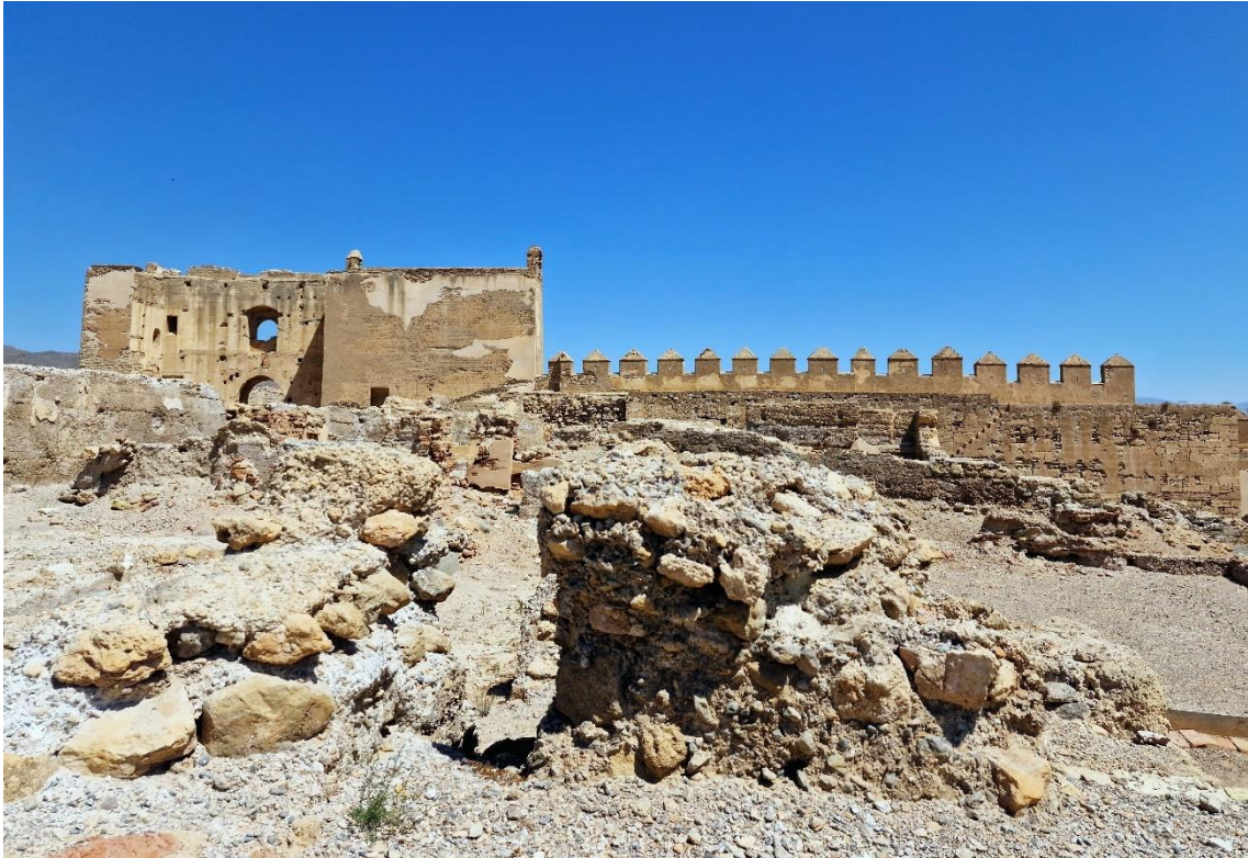
Fotografía 5.4: cara interna de las murallas septentrionales de la Alcazaba, a la altura de la Torre de la Odalisca. Las murallas musulmanas fundacionales y post fundacionales, que protegieron a la Ciudad, estaban apoyadas en las caras externas de las murallas de la Alcazaba. Captura del 23 de agosto de 2023.
