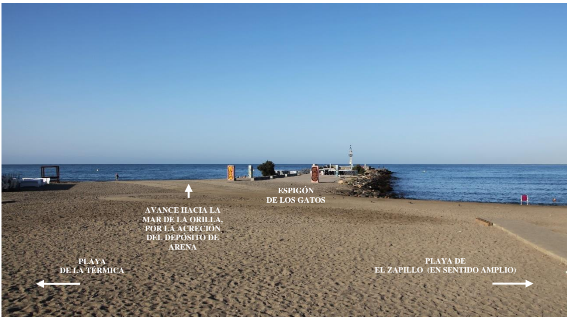
Fotografía 2.23: vista del Espigón de Los Gatos, desde su inicio en la orilla, hacia mar adentro. En la Playa de El Zapillo, los procesos de acreción-erosión (de ganancias-pérdidas de arenas) estuvieron, y están, impactados, negativamente, por las actuaciones del Hombre. En un pasado reciente, y ahora, el Espigón de La Térmica, o de Los Gatos, interrumpía, e interrumpe, de forma significativa, la llegada de la arena a la Playa de El Zapillo, desde la desembocadura del Río Andarax. Las arenas de acreción eran, y son, transportadas por las corrientes de deriva, ligadas al oleaje de levante. La imagen verifica que, ante la interrupción del transporte sedimentario por el Espigón, las arenas se depositaban, y se depositan, en la cara oriental de la estructura de ingeniería, mientras que, al poniente del mismo, el depósito de arenas quedaba, y queda, sin recibir nuevos aportes, que mitigaran, y mitiguen las pérdidas sedimentarias por los oleajes erosivos de poniente, en el supuesto de que no funcionaran las medidas de la estabilización sedimentaria. Por esta interrupción en el transporte sedimentario, se originó, en el pasado, una erosión neta, y cada vez más progresiva, en el conjunto de la Playa de El Zapillo. Captura del 26 de julio de 2023.
