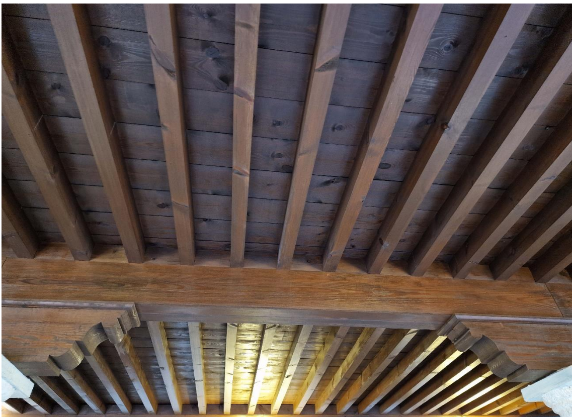
Fotografías 7.53 y 7.54: techo plano lignario simple, con un solo orden de vigas (las jácenas, que dan apoyo a las tablazones). Hay añadida una relevante viga central de madera, apoyada en dobles canecillos lignarios sobre columnas. Coro Bajo de la Iglesia de Las Puras (Almería). Capturas del 28 (imagen superior) y del 27 (imagen inferior) de noviembre de 2023.
