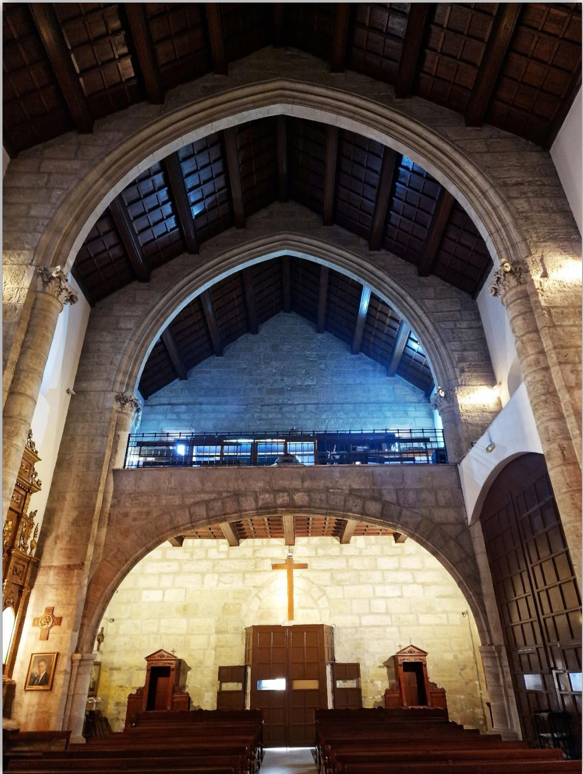
Fotografía 7.38: Iglesia de Santiago (Almería). Techos lignarios de alfarjes, a dos aguas, de la modalidad par e hilera, sobre arcos diafragmas de cantería. La observación se hace hacia el coro (hacia la entrada). Captura del 9 de diciembre de 2023.
