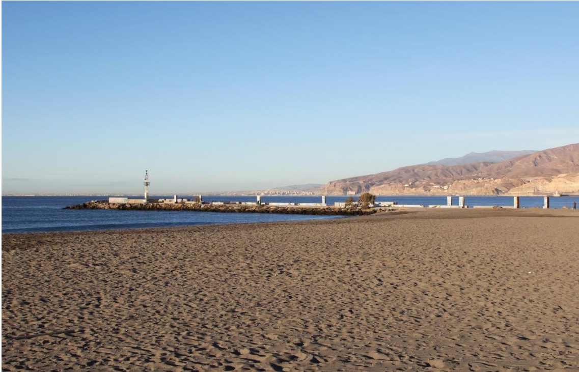
Fotografía 2.22: Espigón de Los Gatos (heredero del Espigón de La Térmica), que interfiere el transporte de deriva de las arenas de acreción, desde la desembocadura del Río Andarax, hacia la Playa de El Zapillo, con el oleaje del levante. Captura del 29 de noviembre de 2022.
