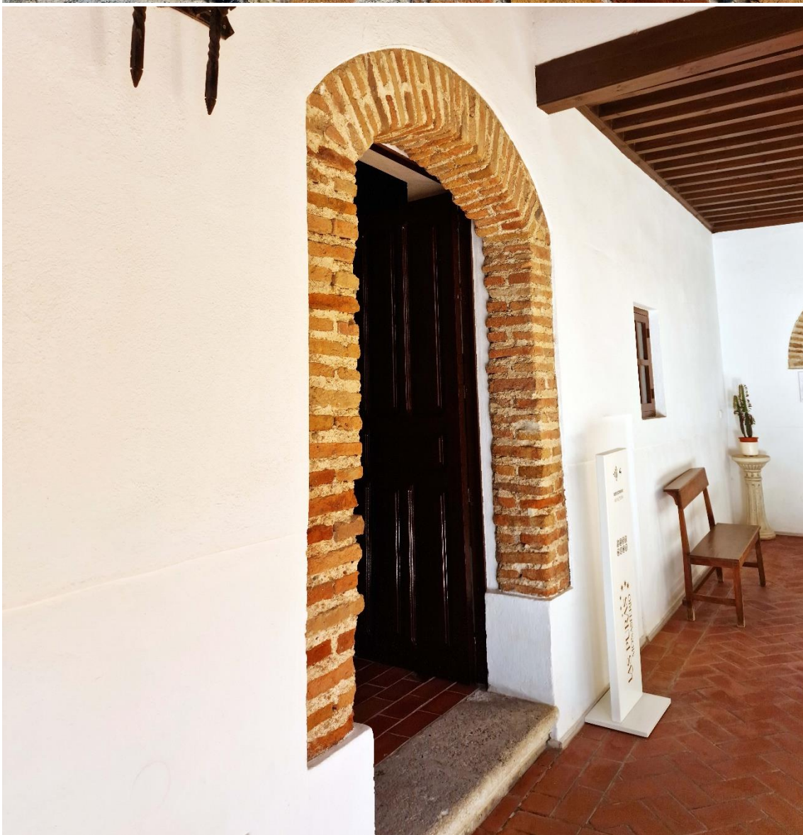
Fotografías 7.31 y 7.32: entorno perimetral del Claustro del Convento de Las Puras (Almería). Detalle de la mampostería con bloques de piedra no talladas (imagen superior), y vista de dovelas con ladrillos de arcilla (imagen inferior), en la parte Mudéjar del Convento. Capturas del 27 y del 30 de noviembre de 2023.
