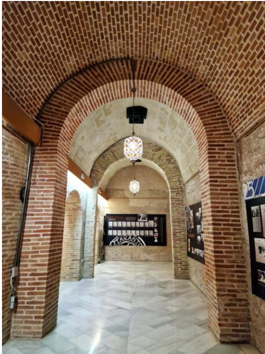
Fotografías 7.74 y 7.75: vistas parciales de los Aljibes de Jayrán (principios del siglo XI), en donde destacan las dovelas de ladrillos de arcilla. Están situados en la actual Calle Tenor Iribarne. Estos Aljibes recogían el agua de las fuentes de Alhadra, mediante un canal de 6.5 km. Tenían una capacidad para almacenar unos 630 000 litros de agua. Desde estos Aljibes, se distribuía el agua al resto de la al-Mussalla, a través de canales y fuentes. Capturas del 5 de agosto de 2023.
