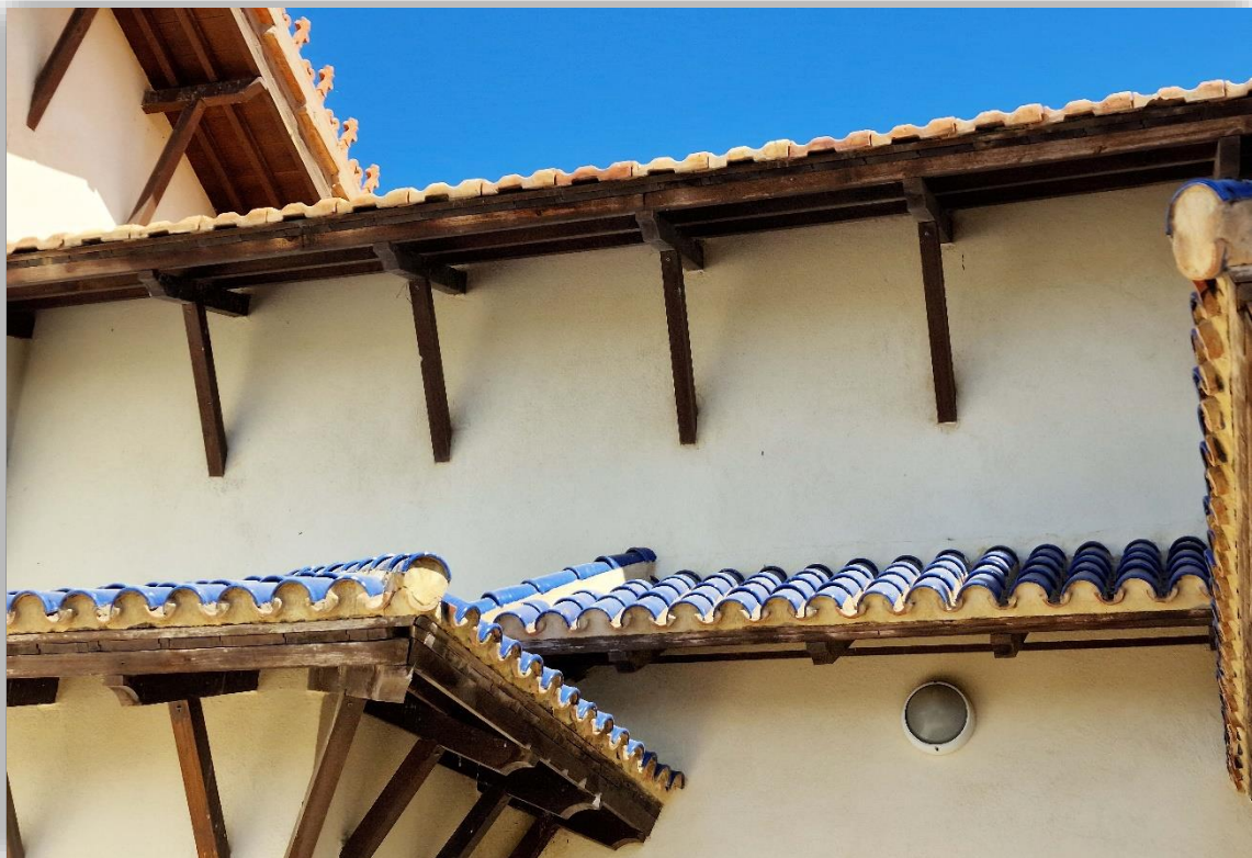
Fotografías 7.78 y 7.79: tejas vidriadas de color azul, en la Casa Balmas (Casa del Cine), entre el Camino Romero y la Calle Francia. La Casa fue construida en 1866, con mejoras y ampliaciones posteriores. Capturas del 17/8/2023.
