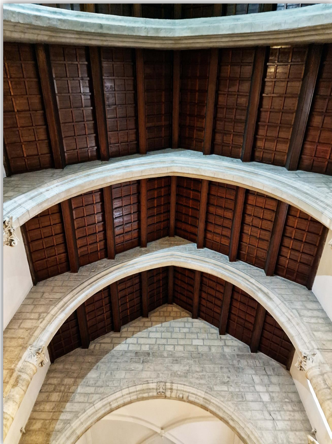
Fotografía 7.37: Iglesia de Santiago (Almería). Techos lignarios de alfarjes, a dos aguas, de la modalidad par e hilera, apoyados en arcos diafragmas de cantería. La observación se hace hacia el retablo (hacia el testero). Este techo cubre toda la nave del templo. Captura del 9 de diciembre de 2023.
