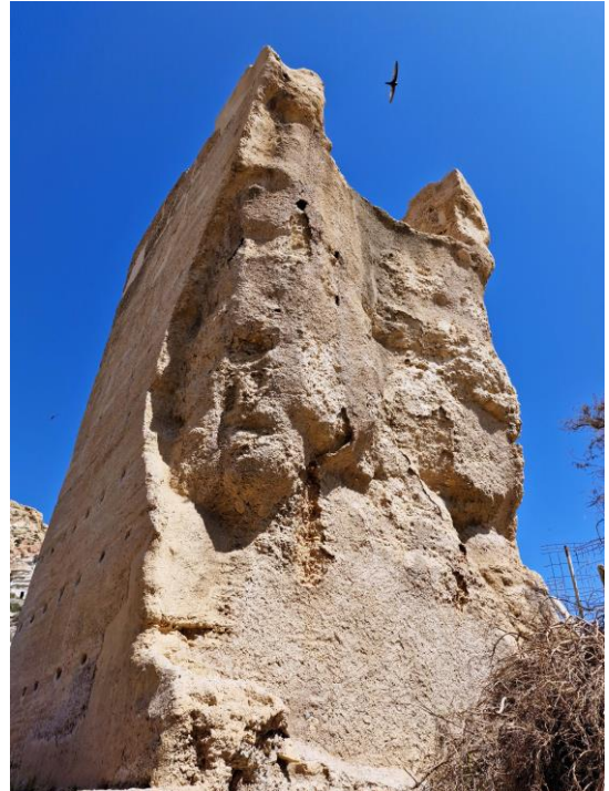
Fotografías 5.16, 5.17 y 5.18 (de arriba abajo y de izquierda a derecha): Torreón de la Calle Valdivia (restos de las murallas musulmanas post fundacionales más occidentales). Destaca el tapial (en la imagen inferior derecha), que ha quedado al descubierto, empleado en este sector de las murallas musulmanas. La Calle Valdivia es una prolongación de la Calle Cordoneros. Barriada de la Pescadería-La Chanca. Capturas del 26 (imágenes superior e inferior izquierda) y del 25 (imagen inferior derecha) de agosto de 2023.
