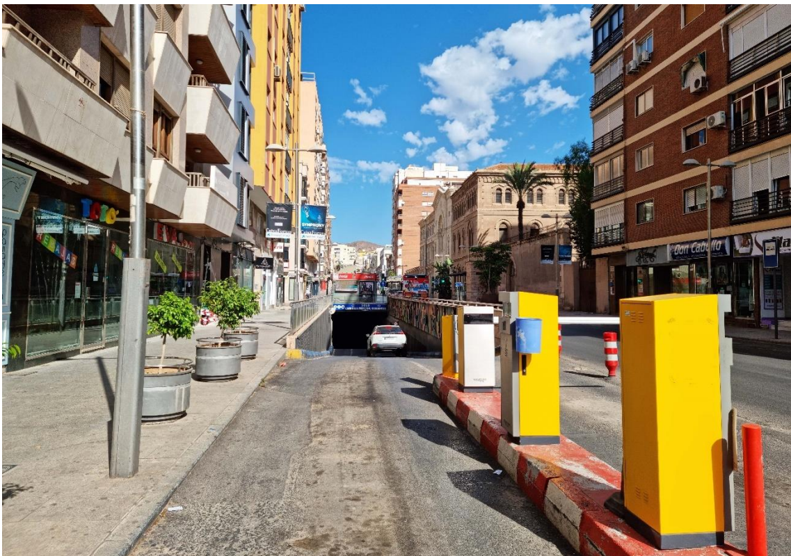
Fotografía 2.3: acceso al aparcamiento subterráneo de la Calle Obispo Orberá, desde la Avenida Federico García Lorca. Este aparcamiento es una rehabilitación de una parte del cauce embovedado, de la Rambla Alfáreros. Captura del 15 de agosto de 2022.
