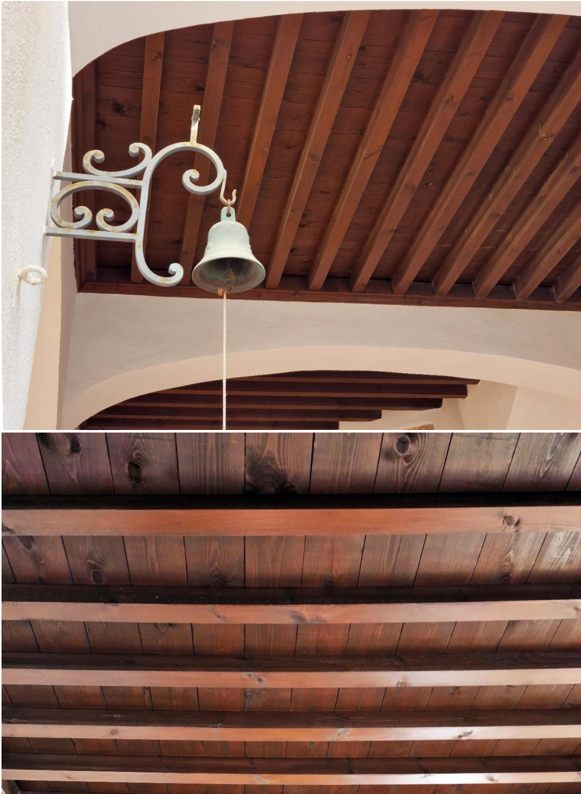
Fotografías 7.49 y 7.50: techo plano lignario simple, con un solo orden de vigas (las jácenas, que dan apoyo a las tablazones). Claustro Inferior del Convento de Las Puras (Almería), del siglo XVI. Capturas del 28 (imagen superior) y del 27 (imagen inferior) de noviembre de 2023.
