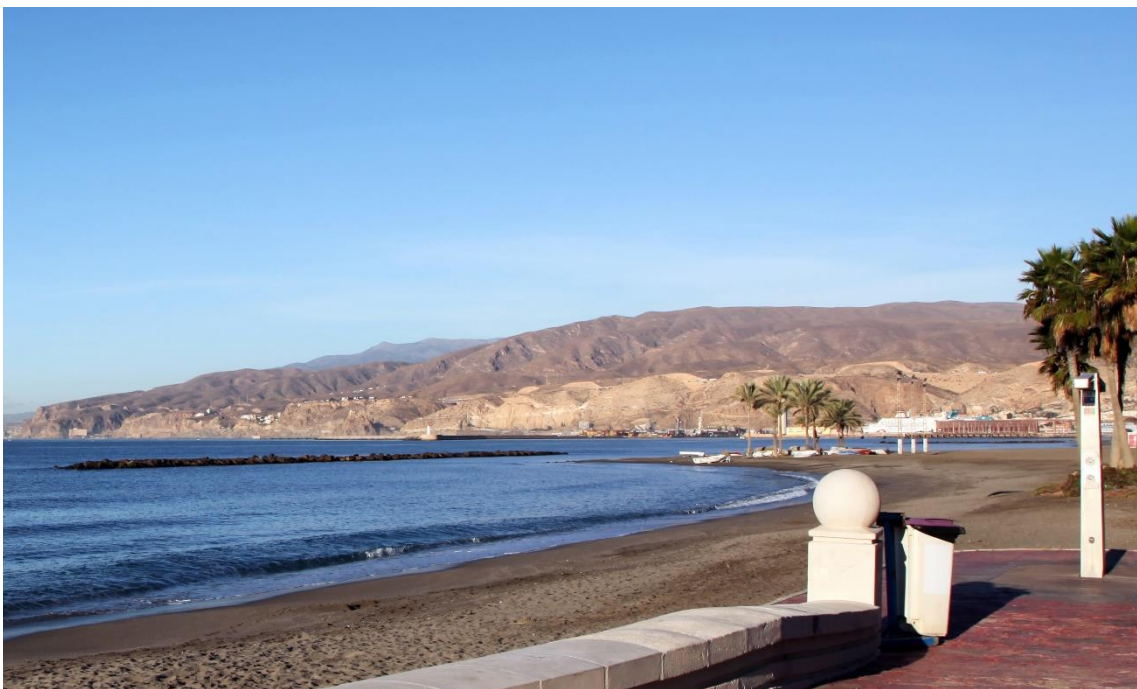
Fotografía 2.25: dique exento (obra marítima paralela a la orilla) para estabilizar el depósito de arena de la Playa de El Zapillo, tras su regeneración sedimentaria artificial. Las corrientes por gradientes de sobre elevación del agua de la mar, provocadas por el dique exento, crean, y/o mantienen, un semi tómbolo (llamado hemitómbolo en Ingeniería Costera), que podría, potencialmente, evolucionar a un tómbolo. Captura del 29 de noviembre de 2022.
