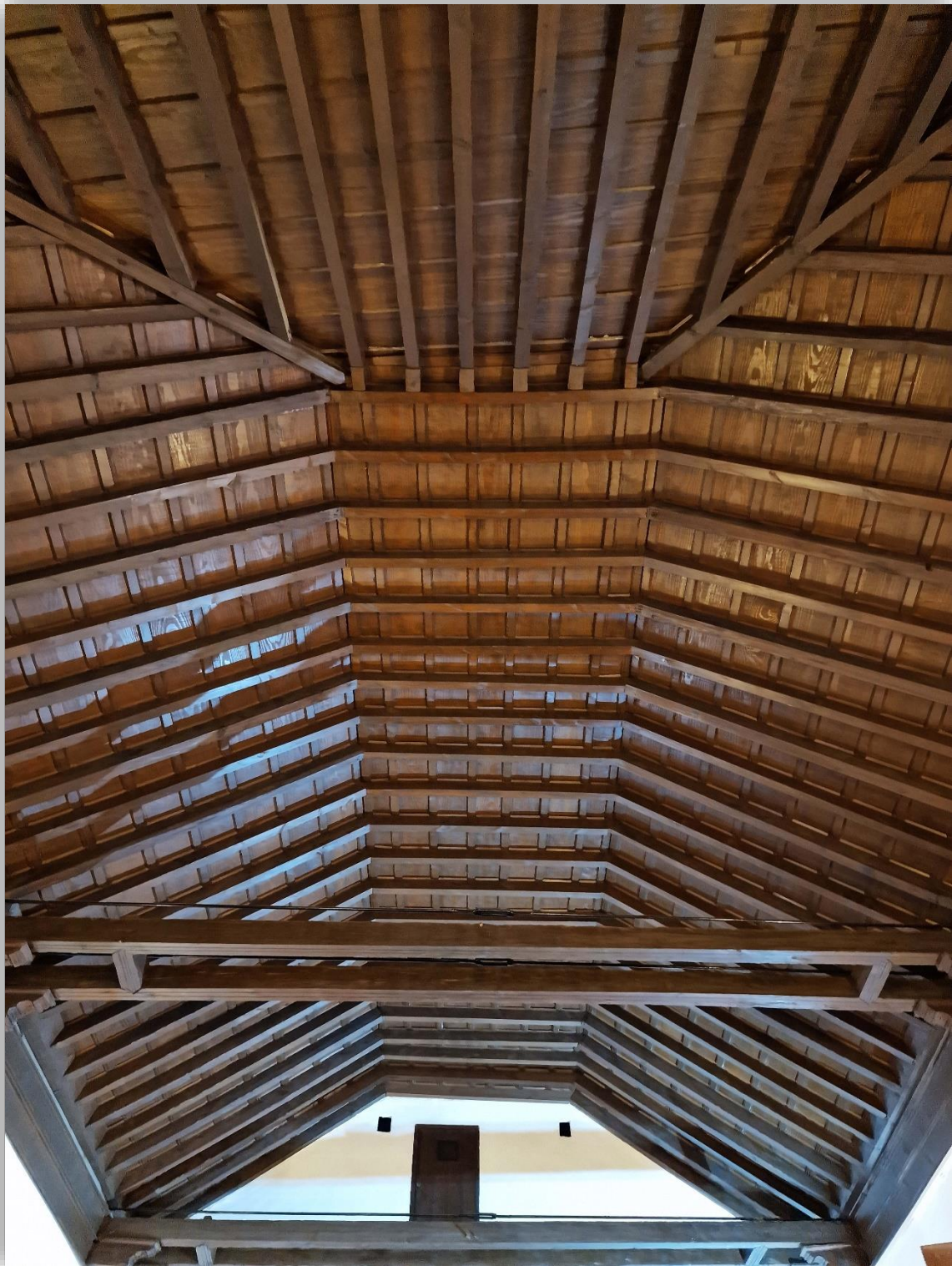
Fotografía 7.44: artesanado del Coro Alto de la Iglesia, en el Convento de Las Puras (Almería). La cubierta, de la modalidad par y nudillo, está considerada como original. Se libró de los daños colaterales de la Guerra Civil Española de 1936-1939. Captura del 27 de noviembre de 2023.
