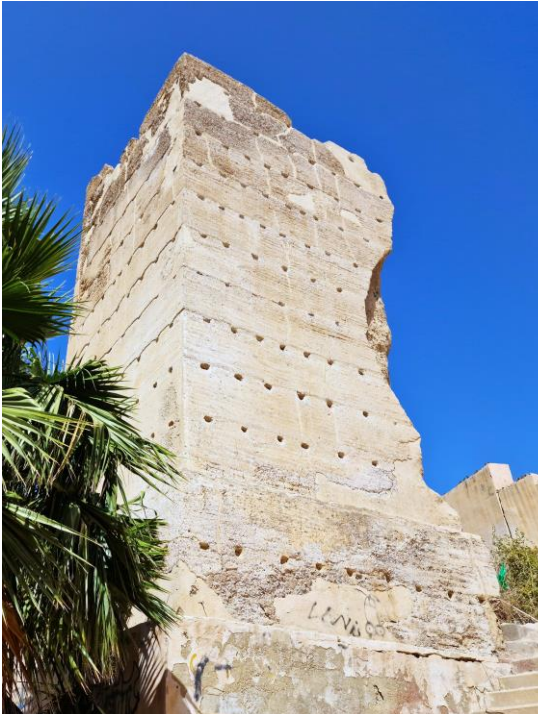
Fotografías 5.16, 5.17 y 5.18 (de arriba abajo y de izquierda a derecha): Torreón de la Calle Valdivia (restos de las murallas musulmanas post fundacionales más occidentales). Destaca el tapial (en la imagen inferior derecha), que ha quedado al descubierto, empleado en este sector de las murallas musulmanas. La Calle Valdivia es una prolongación de la Calle Cordoneros. Barriada de la Pescadería-La Chanca. Capturas del 26 (imágenes superior e inferior izquierda) y del 25 (imagen inferior derecha) de agosto de 2023.
