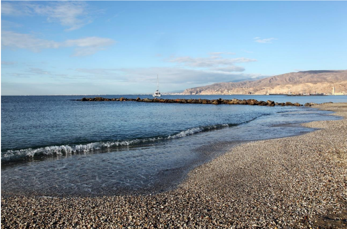
Fotografía 2.24: espigón transversal entre el de Los Gatos y el dique exento, para estabilizar el depósito de arena de la Playa de El Zapillo, tras su regeneración sedimentaria. El fondo escénico de la imagen está formado por algunas estribaciones, las más orientales, de la Sierra de Gádor. Captura del 3 de diciembre de 2022.
