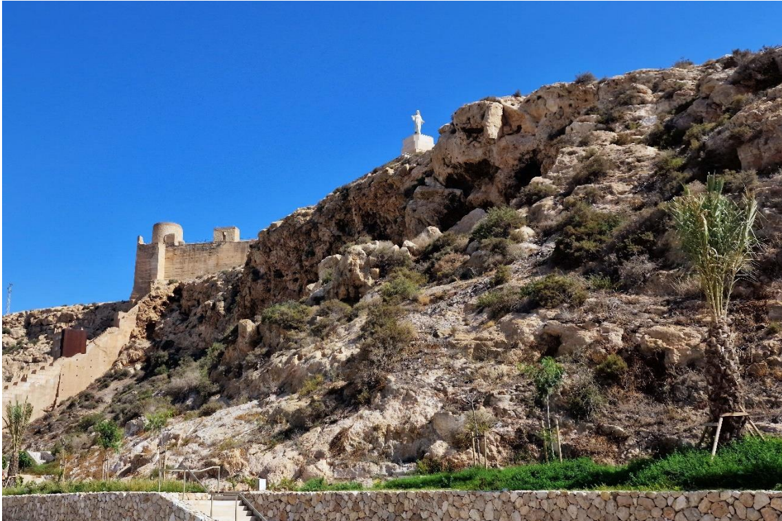
Fotografía 5.10: a la izquierda de la imagen, se observa la cohabitación entre los torreones cilíndricos cristianos y los de planta rectangular musulmanes, en el Cerro de San Cristóbal. Captura del 18 de agosto de 2023.
