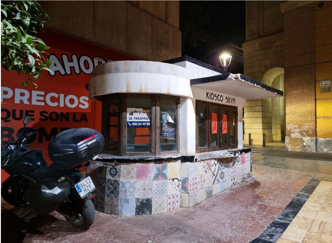
Fotografías 6.1 y 6.2: kiosco en la Plaza Urrutia. Es uno de los construidos sobre las bocas de Los Refugios, construidos durante la Guerra Civil Española de 1936-1939. Algunas de estas bocas se rehabilitaron como kioscos-tapaderas, que tuvieron la funcionalidad de kioscos de prensa. Los kioscos tapadera fueron proyectados y levantados bajo la dirección de don Guillermo Langle Rubio. Capturas del 16 y 14 (de arriba abajo) de agosto de 2022.
