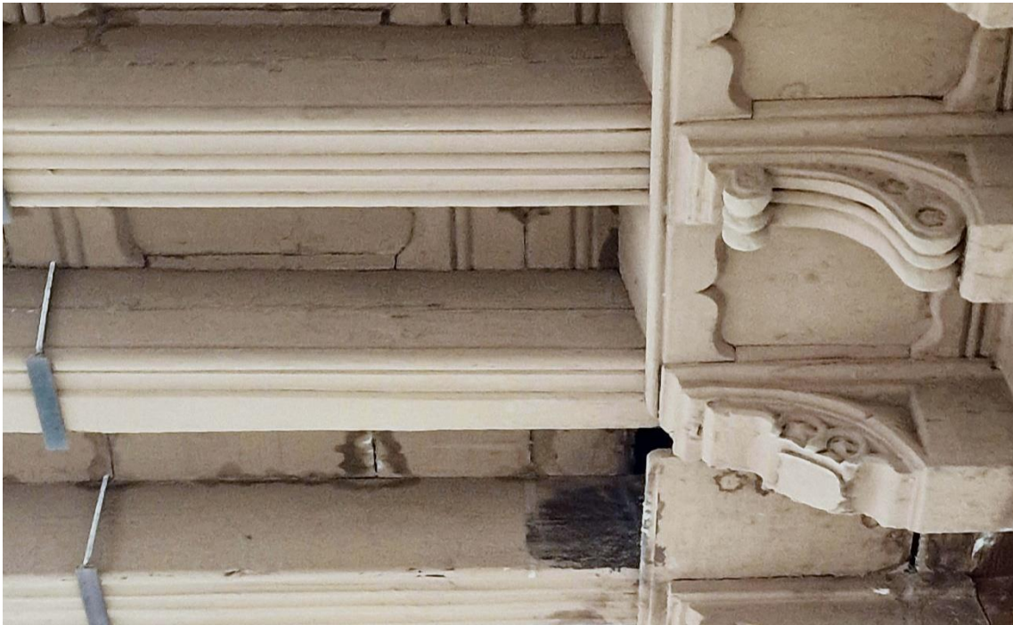
Fotografía 7.60: vista lateral de los canecillos, que sirven de apoyo a las vigas del techo plano lignario ataujerado. La cubierta, en su conjunto, fue tratada, en su tiempo, con una pintura preparada con limos y arcillas (tierra), en un aceite secante (como el aceite de ricino o de linaza). Taller de Carpintería de la Escuela de Arte y Superior de Diseño Carlos Pérez Siquier (Almería). Este Taller es una sala anexa al patio rodeado por el claustro del desamortizado Convento de Santo Domingo el Real. Captura del 4 de diciembre de 2023.
