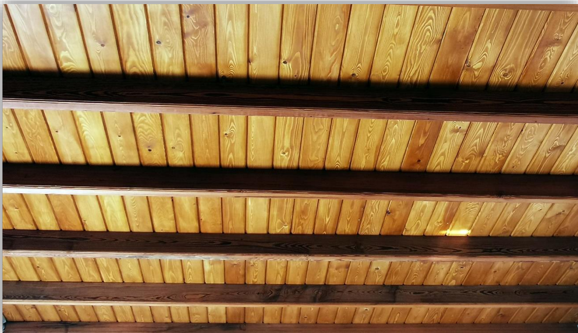
Fotografías 7.65 y 7.66: techos sencillos actuales de madera de riga, levantados con tablas machihembradas sin ornamentaciones ni decoraciones, sobre vigas, en una casa de campo de varios siglos de antigüedad. En la restauración, se quiso respetar las percepciones que daban las caras internas de las cubiertas originales de madera, en su pasado. Casa rural de don Juan José García Reyes. Barriada de Llano Parra (Guía de Gran Canaria, Islas Canarias). Capturas del 20 y 30 de septiembre de 2023 (de arriba abajo).
