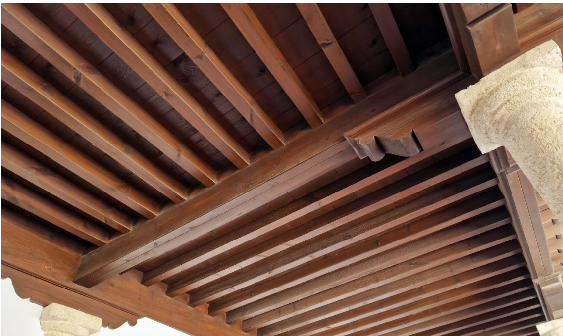
Fotografías 7.51 y 7.52: dos techos planos lignarios simples, con un solo orden de vigas (las jácenas, que dan apoyo a las tablazones), separados en dos secciones por una viga maestra. Los estribos descansan en canecillos dobles apoyados en columnas. Claustro Superior del Convento de Las Puras (Almería). Capturas del 27 de noviembre de 2023.
