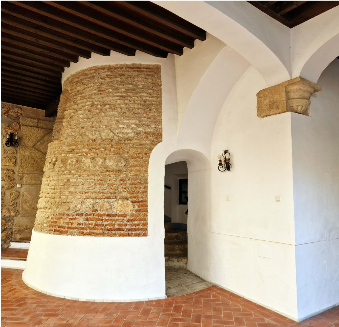
Fotografía 7.33: entorno perimetral del Claustro del Convento de Las Puras (Almería). Se observa el empleo de ladrillos de arcilla, en la construcción de paredes, en la parte Mudéjar del Convento. Captura del 27 de noviembre de 2023.
