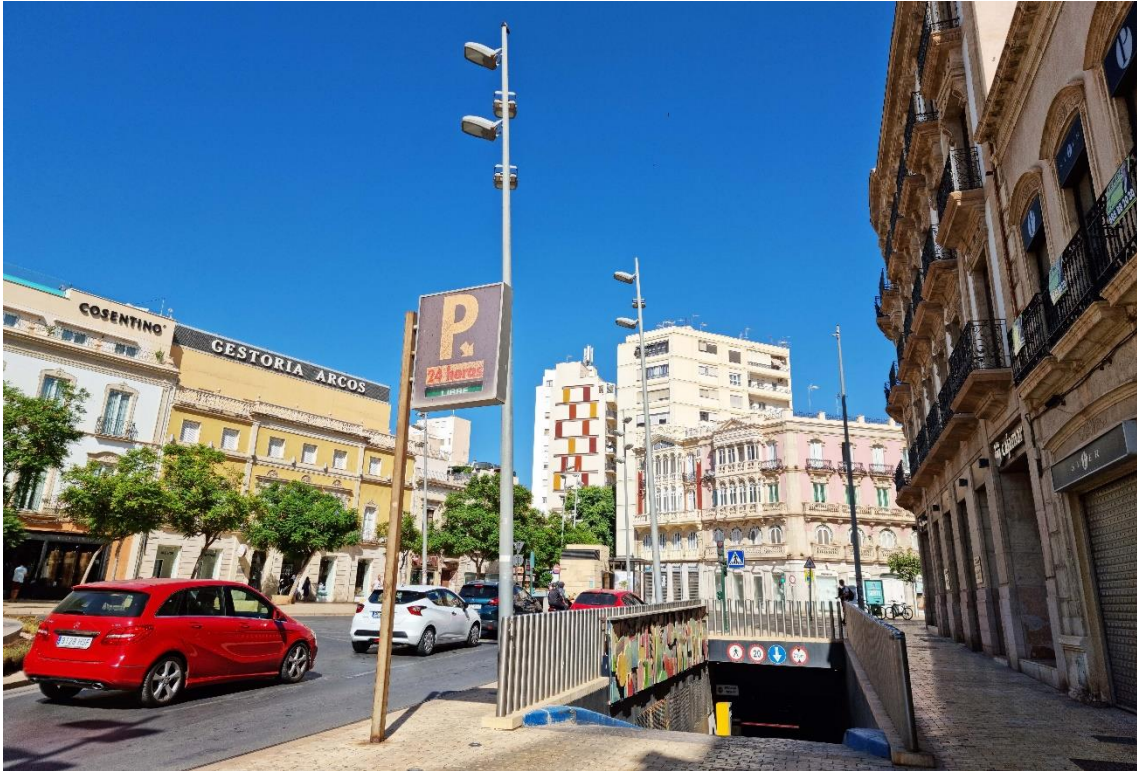
Fotografía 2.2: uno de los accesos al aparcamiento subterráneo de la Puerta de Purchena. El aparcamiento se corresponde con una rehabilitación de una parte del cauce embovedado, de la Rambla Alfáreros. Captura del 15 de agosto de 2022.
