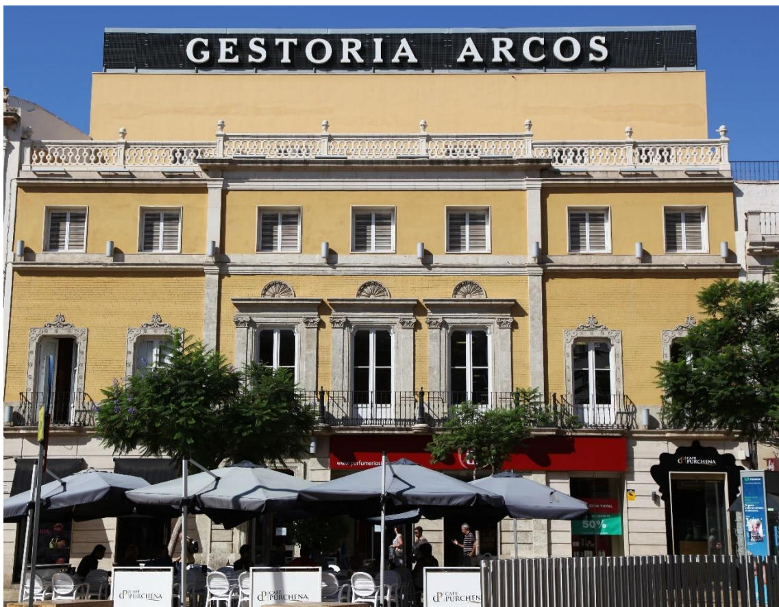
Fotografía 8.106: casa historicista en la Puerta de Purchena. Su frontis está restaurado. Sobre su terrazo, se ha construido, en la actualidad, una nueva altura retranqueada (un remonte). Captura del 16 de agosto de 2013.
