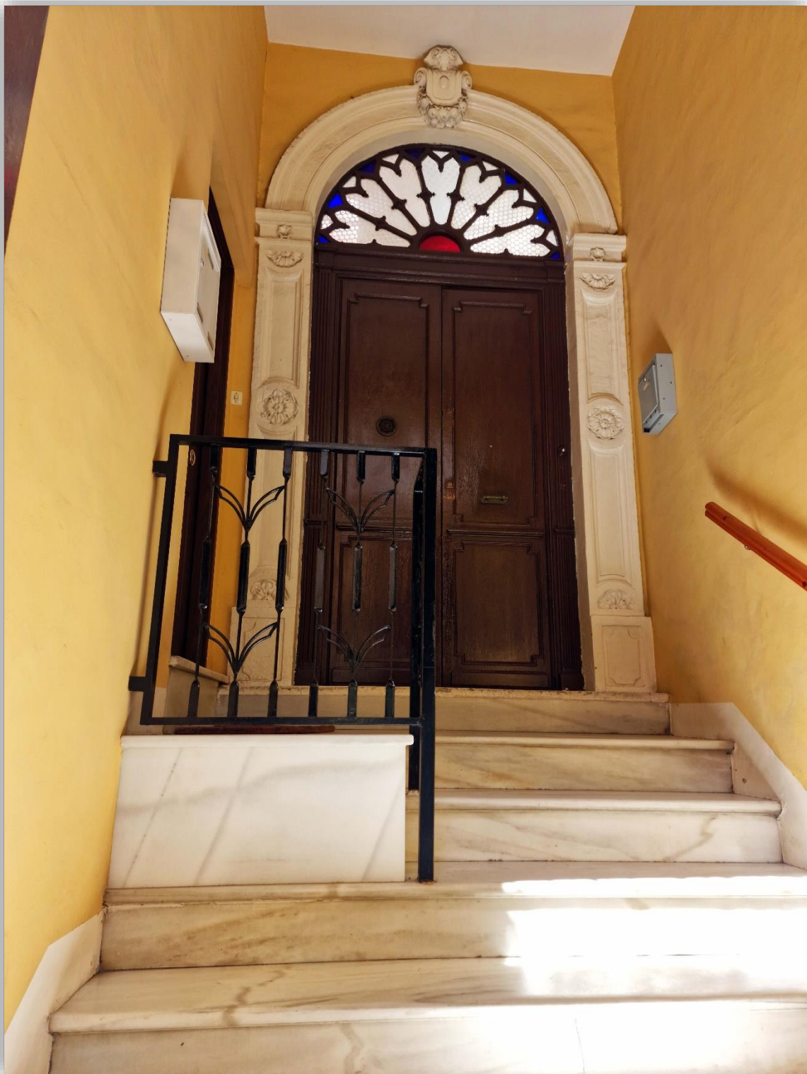
Fotografía 8.67: zaguán de la casa nº 44, de la Calle Real. Adquieren notabilidad los peldaños en mármol de las escaleras, y el tragaluz acristalado de medio punto, que corona la puerta interna de acceso a la vivienda principal. Captura del 28 de julio de 2023.
