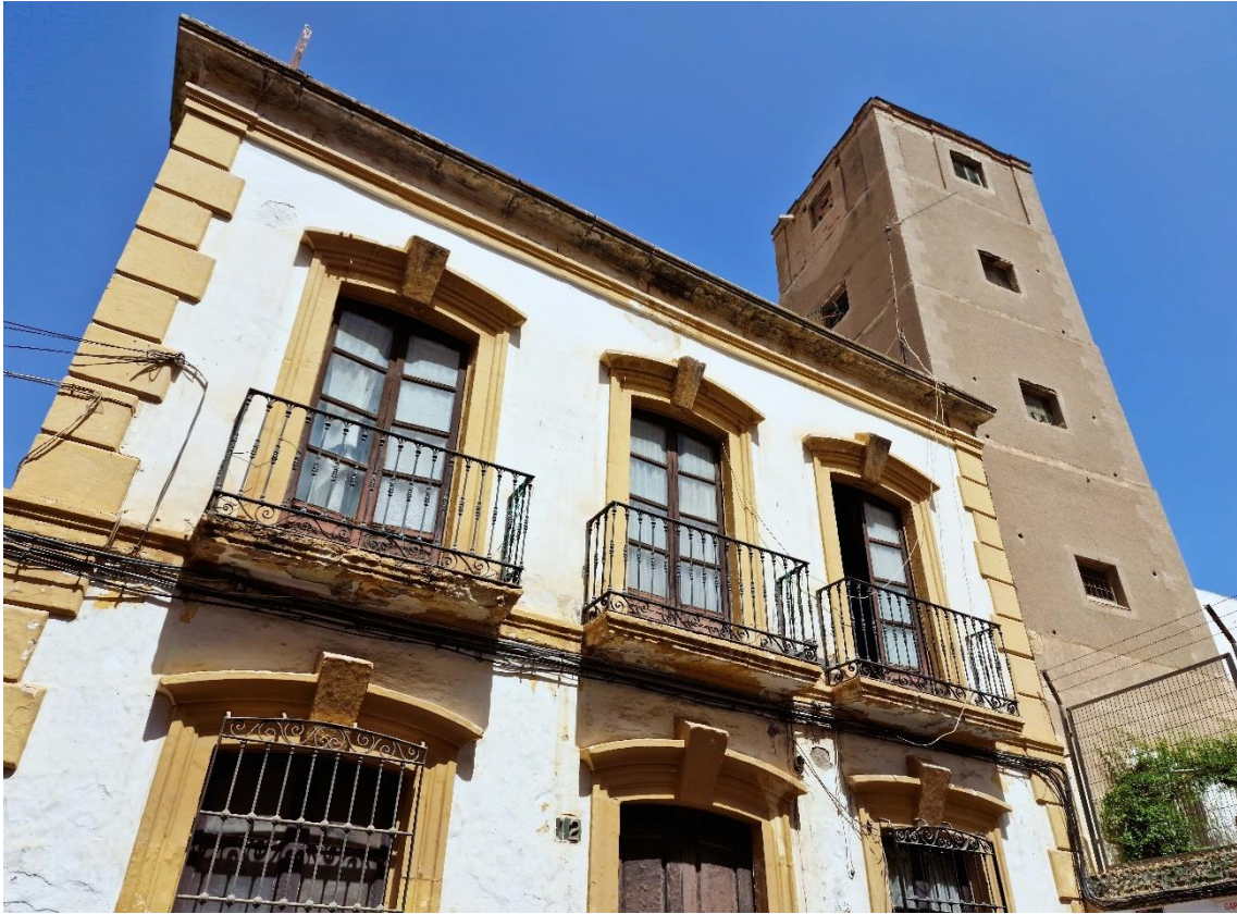
Fotografía 8.58: casona burguesa con tipología edificatoria externa del Mediterráneo más occidental. Calle Relámpago, nº 12. A la derecha, se encuentra el Torreón de los Perdigones. Captura del 7 de agosto de 2023.
