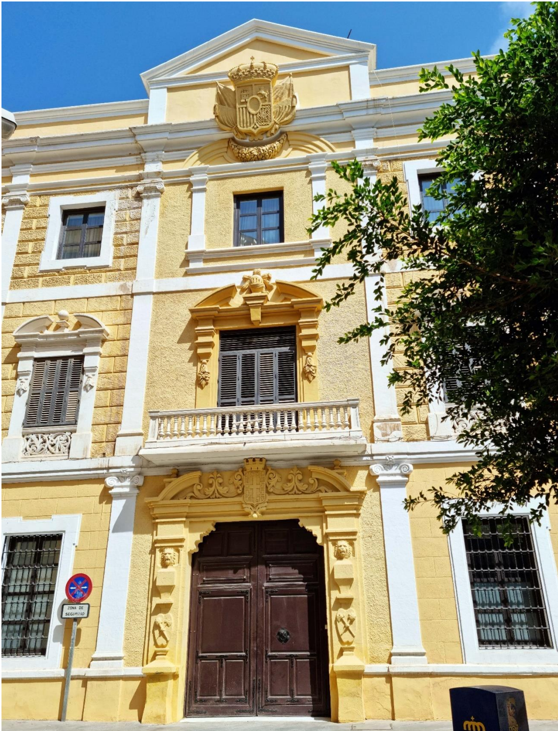
Fotografía 8.206: frontón en detalle, del Cuartel de la Misericordia construido entre 1784 y 1887, con un estilo arquitectónico historicista. Plaza del Cristo de la Buena Muerte. Captura del 23 de julio de 2022.
