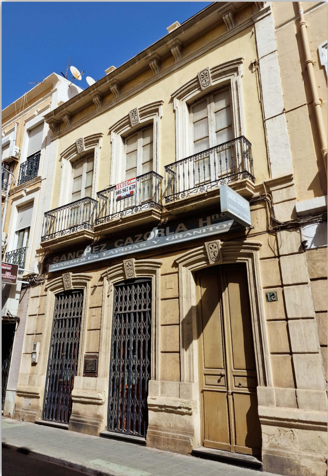
Fotografía 8.88: edificio historicista, con una mínima restauración, en la Calle Granada, nº 12. Destaca la sobriedad de las barandillas de hierro en los balcones, y las decoraciones de las claves, en los arcos de los balcones. Captura del 30 de julio de 2023.
