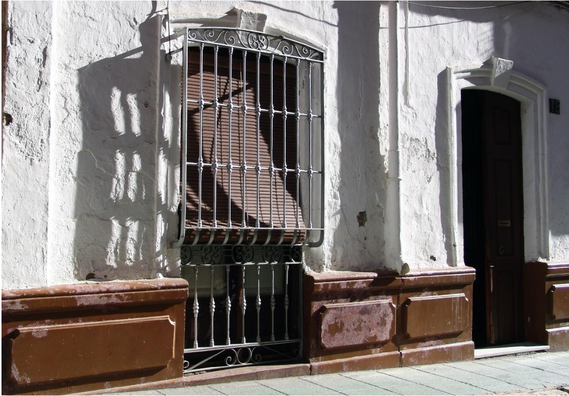
Fotografía 8.50: casa popular del Mediterráneo más occidental, para usuarios con economía media, en la Calle Magistral Domínguez, nº 18 (próxima a la que tenía, en su momento, el nº 14). El zócalo de granito artificial, de coloración roja, está barnizado. Lo habitual era la ausencia de este barnizado. Captura del 28 de diciembre de 2007.
