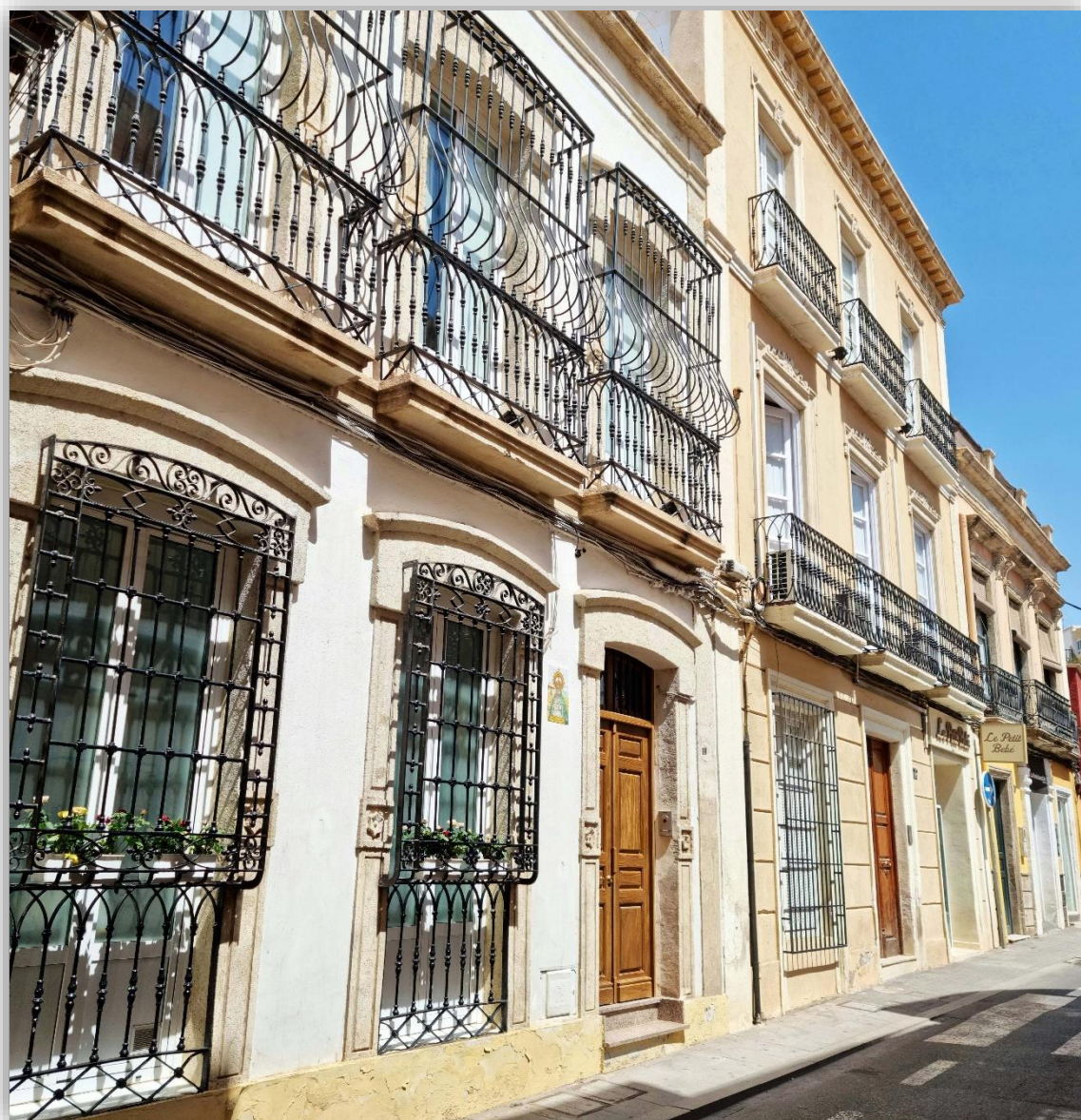
Fotografía 8.100: casas historicistas de la Calle Real. En un primer plano, casa nº 74. En su primera altura, las ventanas, de un cuerpo, están cerrados por rejas balconeras. En su segunda altura, hay balcones con rejas en jaula, que desarrollan, en la parte superior, morfologías de pecho palomo . Captura del 23 de julio de 2022.
