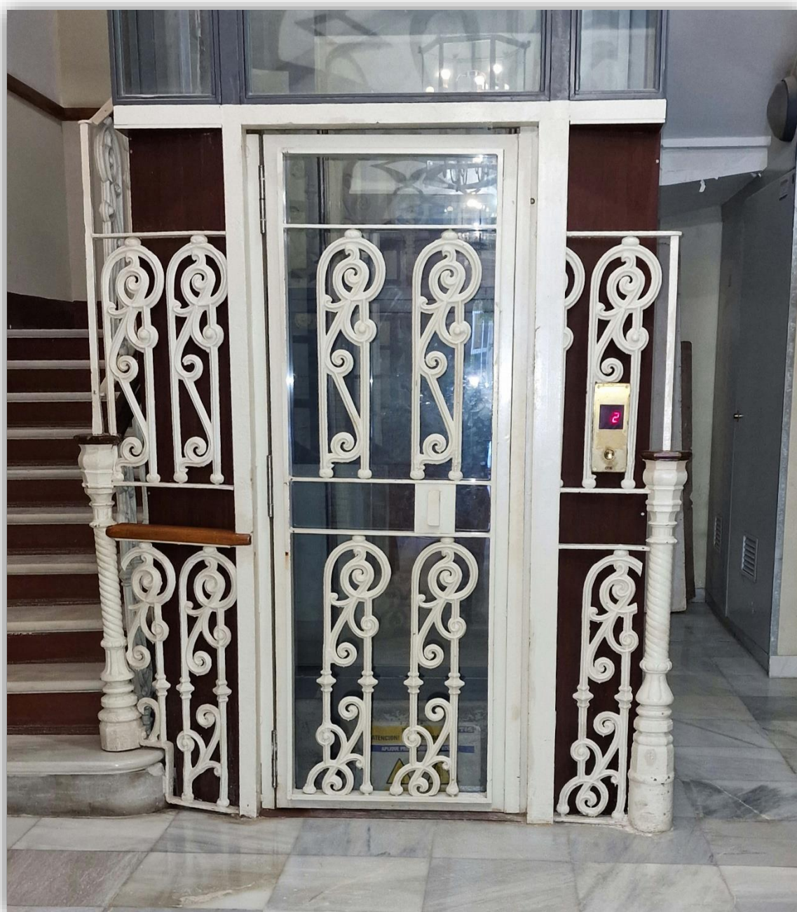
Fotografía 8.154: caja externa, en hierro pintado de blanco, del ascensor del Edificio Peña (El Paseo, nº 81). En este edificio, se instaló el primer ascensor de la Ciudad de Almería, en el año 1941. El actual ascensor ha respetado el aspecto del original. Captura del 18 de agosto de 2023.
