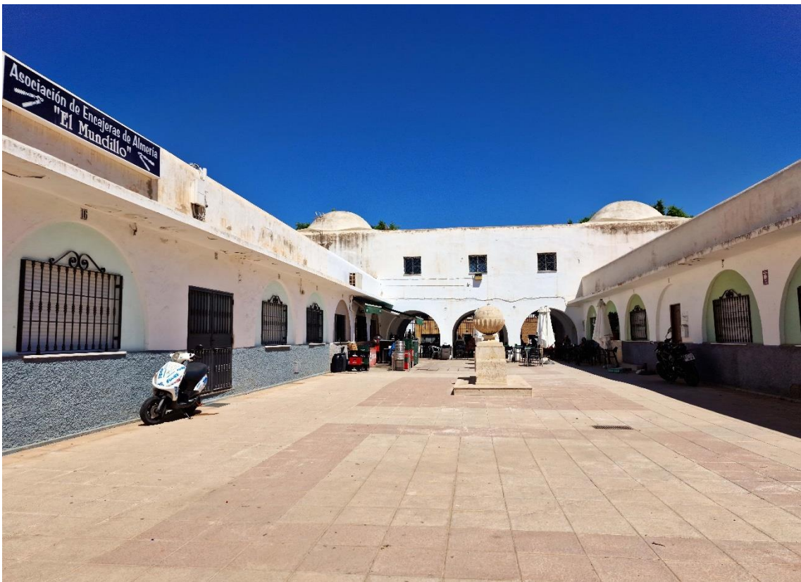
Fotografías 8.38 y 8.39: Plaza del Mercado de Abastos, de Regiones Devastadas, vista desde su extremo septentrional. Los arcos de las galerías laterales porticadas han sido cegados. Capturas del 17 de agosto de 2023.
