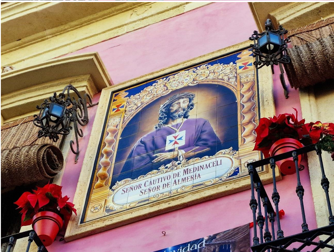
Fotografías 9.10 y 9.11: luminarias adosadas en la fachada de la Casa Rosa, con un estilo modernista en sentido lato, que sirven a la vía pública. Calle Gravina, número 3. Capturas del 10 de diciembre de 2023.
