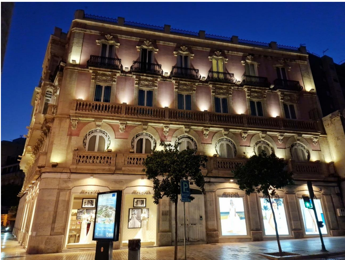
Fotografías 8.137 y 8. 138: fachadas opuestas laterales, con aires modernistas, por las geometrías, los ornatos y las decoraciones en algunas estructuras y en elementos no estructurales, muy perceptibles. Edificio Durbán Quesada-El Río de la Plata, en la Puerta de Purchena. Capturas del 12 de agosto y del 30 de julio de 2023 (de arriba abajo).
