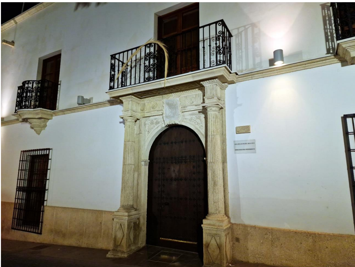
Fotografías 8.159 y 8.160: vista nocturna de la Casa de Los Puche (renacentista-barroca). Siglo XVII. Capturas del 11 de agosto de 2023.
