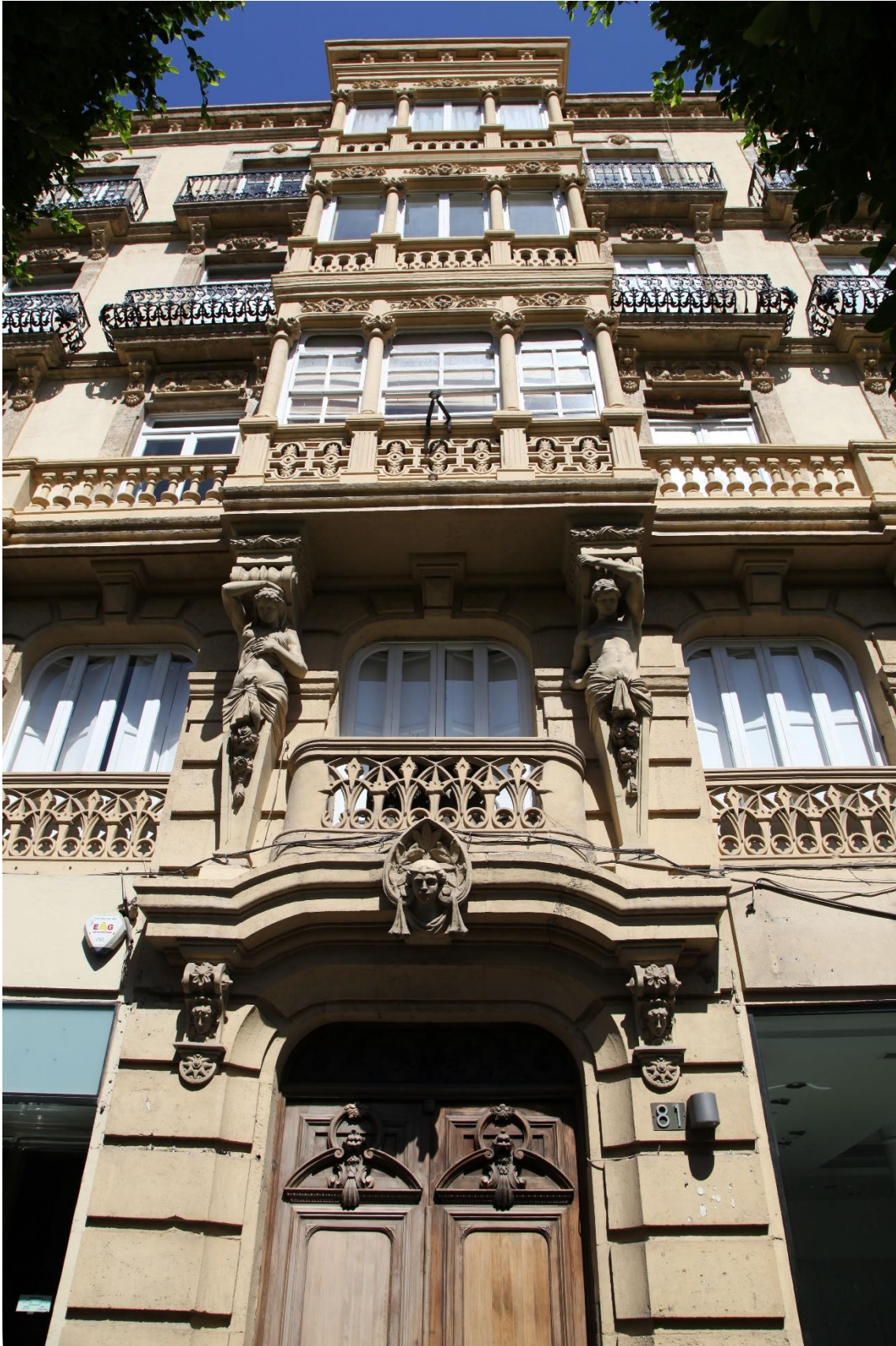
Fotografía 8.150: frontis principal en un conjunto sesgado del Edificio Peña (Casa de los Telamones), de estilo historicista, esquinero entre El Paseo de Almería, la Plaza Circular (de Emilio Pérez) y la Avenida Federico García Lorca. Captura del 31 de julio de 2013.
