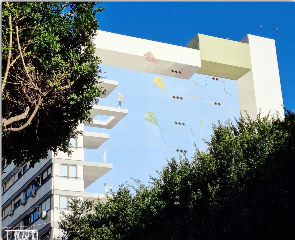
Fotografía 9.17: medianera sur del Edificio del Banco Cajamar, sito en El Paseo de Almería, nº 75. Para mitigar el impacto visual negativo de una medianera desnuda, en el paisaje sensorial urbano, desde cuencas visuales con sus puntos de observación a pie de calle, el tratamiento de la fachada lateral consigue efectos ilusorios ocasionales, que revalorizan las percepciones. En determinados momentos propicios de la posición del sol, en su recorrido de levante a poniente, y en días despejados, aparecen las sensaciones de creer ver cometas de juego suspendidas en el aire, en lugar de percibir las simplemente pintadas en una pared. Cuando se diera el efecto ilusorio en el observador a pie de calle, estarían igualadas las apreciaciones de los tonos del azul, en el cielo y en la medianera tratada. Y de ahí el efecto ilusorio. Captura del 12 de diciembre de 2022.
