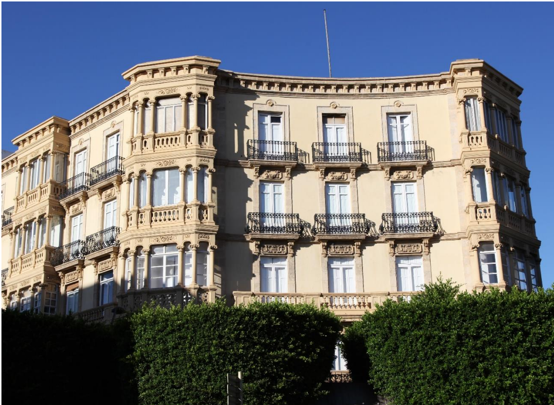
Fotografías 8.148 y 8.149: edificio esquinero (en chaflán) entre El Paseo de Almería, la Plaza Circular (de Emilio Pérez) y la Avenida Federico García Lorca. Es conocido como Edificio Peña. Fue diseñado y construido por el arquitecto don Enrique López Rull, en 1907, como un edificio plurifamiliar. Su tipología edificatoria externa se puede clasificar como historicista, con ciertos rasgos modernistas por cuestiones de asimetría (válidas para la edificación en su conjunto), y por los motivos decorativos de los capiteles (los propios de los órdenes clásicos grecorromanos fueron sustituidos por pétalos de flores), entre otros criterios. Capturas del 28 de agosto de 2012 (superior) y del 29 de agosto de 2012 (inferior).
