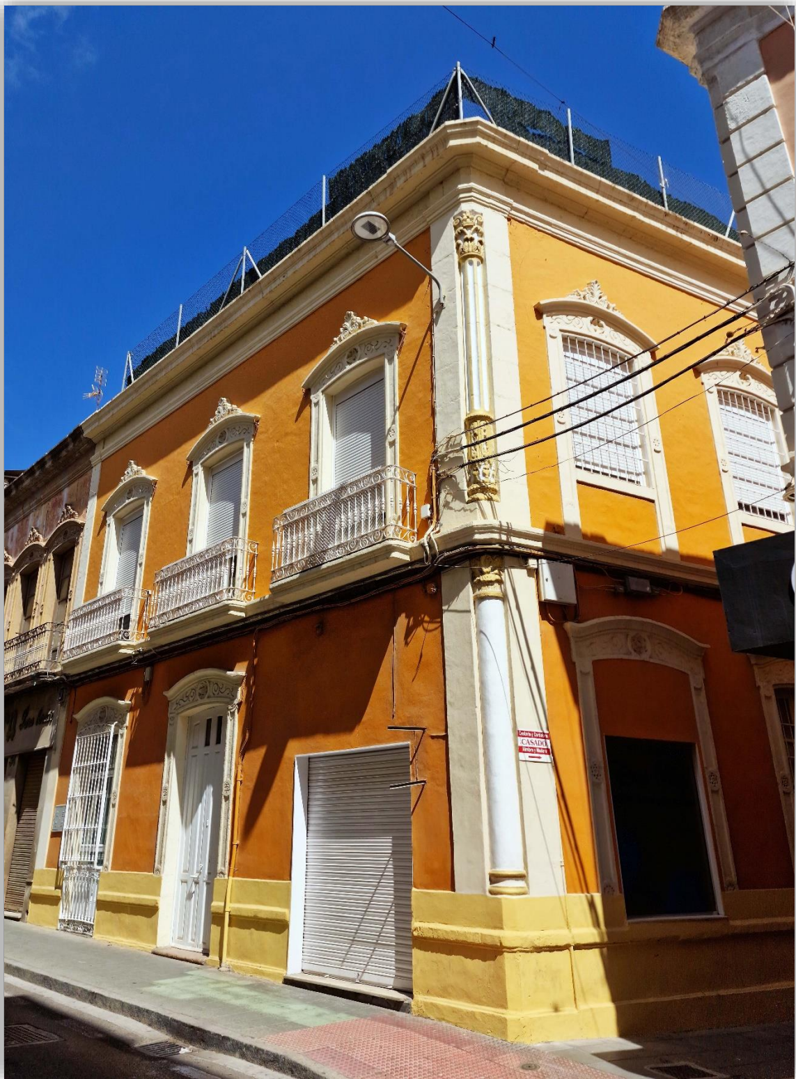
Fotografía 8.89: edificio historicista de la Calle Granada, nº 18. En la imagen, destaca la columna esquinera, que caracteriza, en numerosos casos, al estilo historicista en Almería. Captura del 31 de agosto de 2023.
