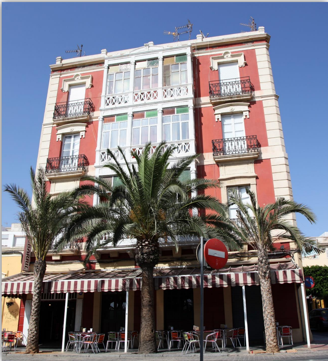
Fotografía 8.131: edificio historicista sobrio en El Paseo de San Luís, esquina con la Calle Arapiles. Destacan sus miradores centrales en línea, con cristaleras de colores en sus remates. Los balcones laterales tienen barandillas de barrotes ornamentados entre cenefas. Toma relevancia la cantería de los dinteles de los balcones, de la cornisa de coronación y de las cadenas pétreas laterales. Captura del 28 de agosto de 2012.
