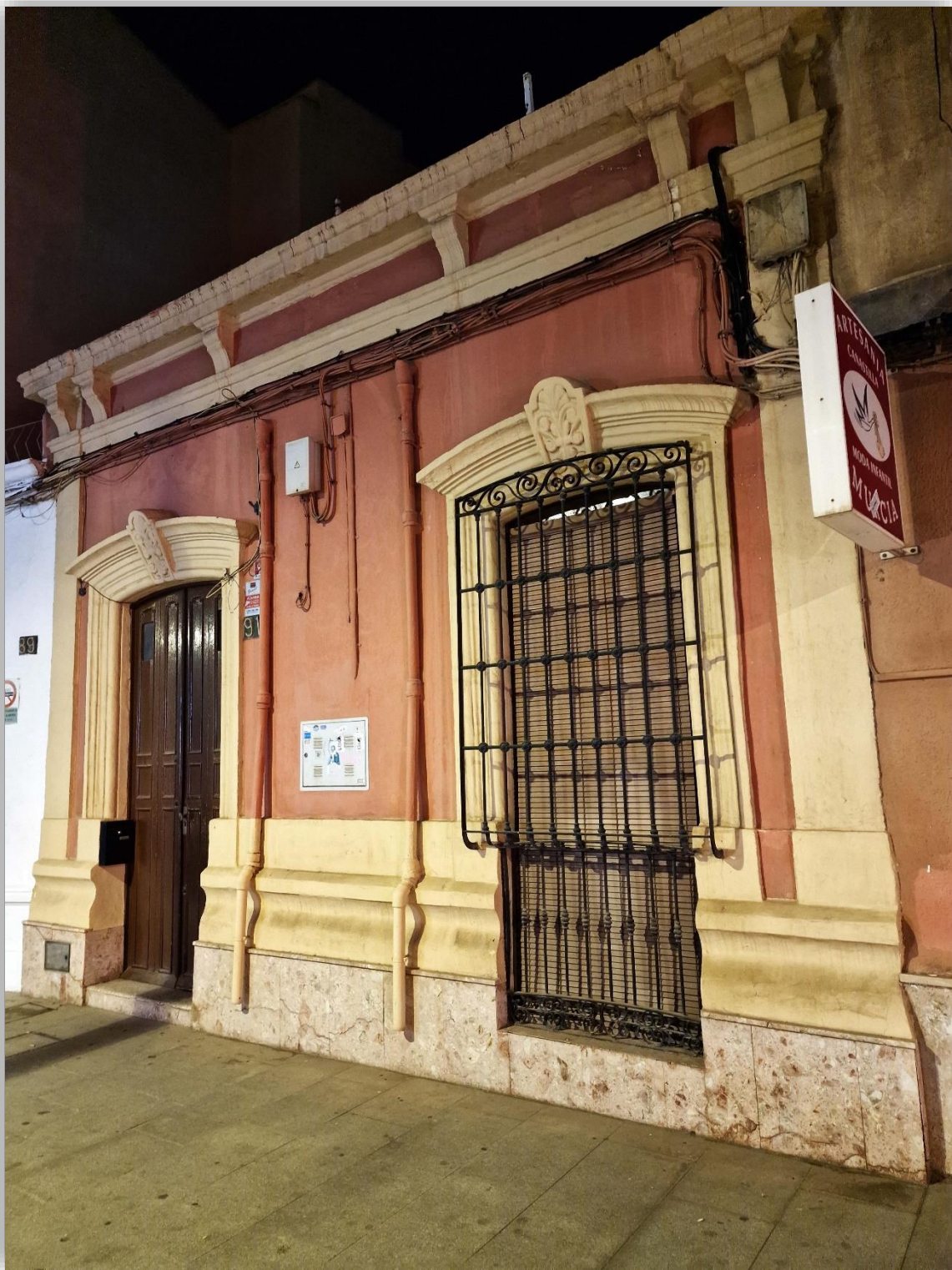
Fotografía 8.54: fachada con aires del estilo externo popular del Mediterráneo más occidental, en una casa con tipología edificatoria externa ecléctica. Calle Murcia, nº 91. Captura del 21 de agosto de 2023.
