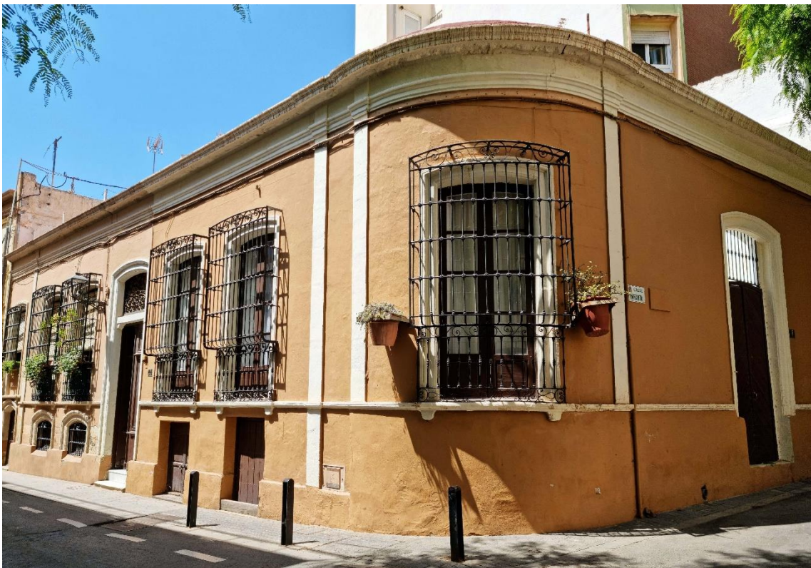
Fotografías 8.65 y 8.66: Calle Real, nº 44 (esquina con la Calle Infanta). Casa burguesa con la tipología edificatoria externa del Mediterráneo en Almería. Toman relevancia los enrejados de las ventanas de un cuerpo y la presencia de un entresuelo. Capturas del 23 de julio de 2022.
