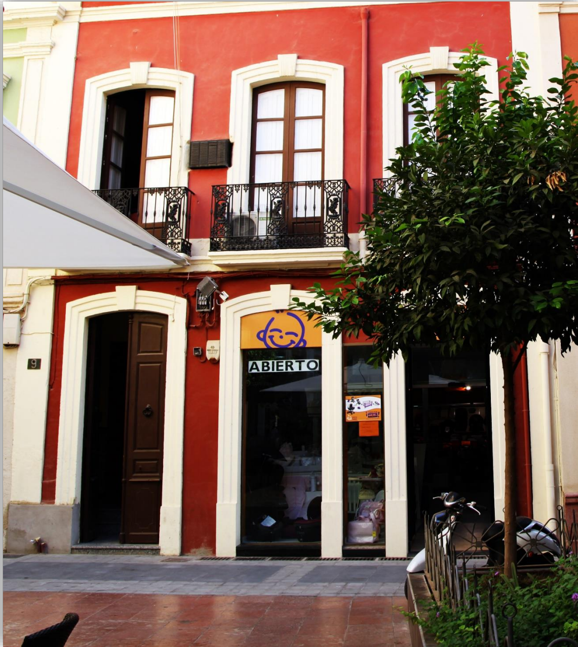
Fotografía 8.57: edificio con una tipología edificatoria externa mediterránea burguesa, en la Plaza Urrutia (Almería). Destacan los balcones con barandillas de herrajes, que incorporan, entre otros elementos, barrotes cilíndricos, barras, y planchas con ornatos en relieve y con dibujos diversos. Captura del 27 de agosto de 2012.
