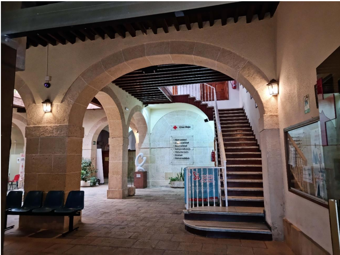
Fotografías 8.127 y 8.128: planta baja del edificio de don Fernando Roda, una vez traspasada la puerta de la calle. La distribución de las estancias, en esta altura, alrededor de un patio de luces con claraboya, y la disposición lateral de las escaleras de acceso a la segunda altura (planta) se diseñaron de acuerdo con las necesidades de disponer de espacio para el almacenaje de mercancías y para la ubicación de oficinas. Capturas del 30 de noviembre de 2022.
