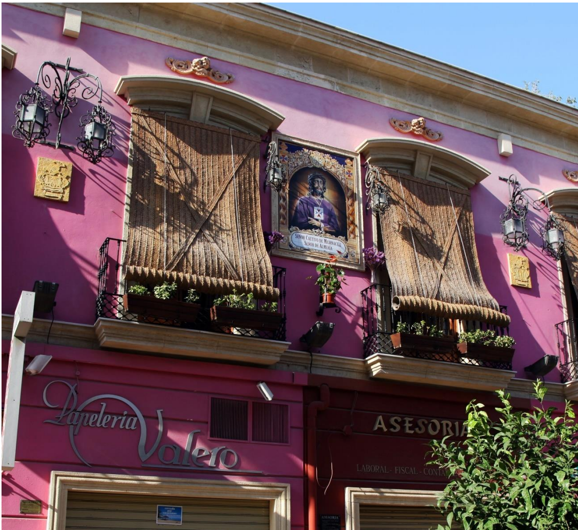
Fotografías 8.95 y 8.96: casa de Cristóbal Romero Rivas, y otras (también historicistas), en la Calle Gravina. Detalles del frontis historicista. Capturas del 21 de agosto de 2013.
