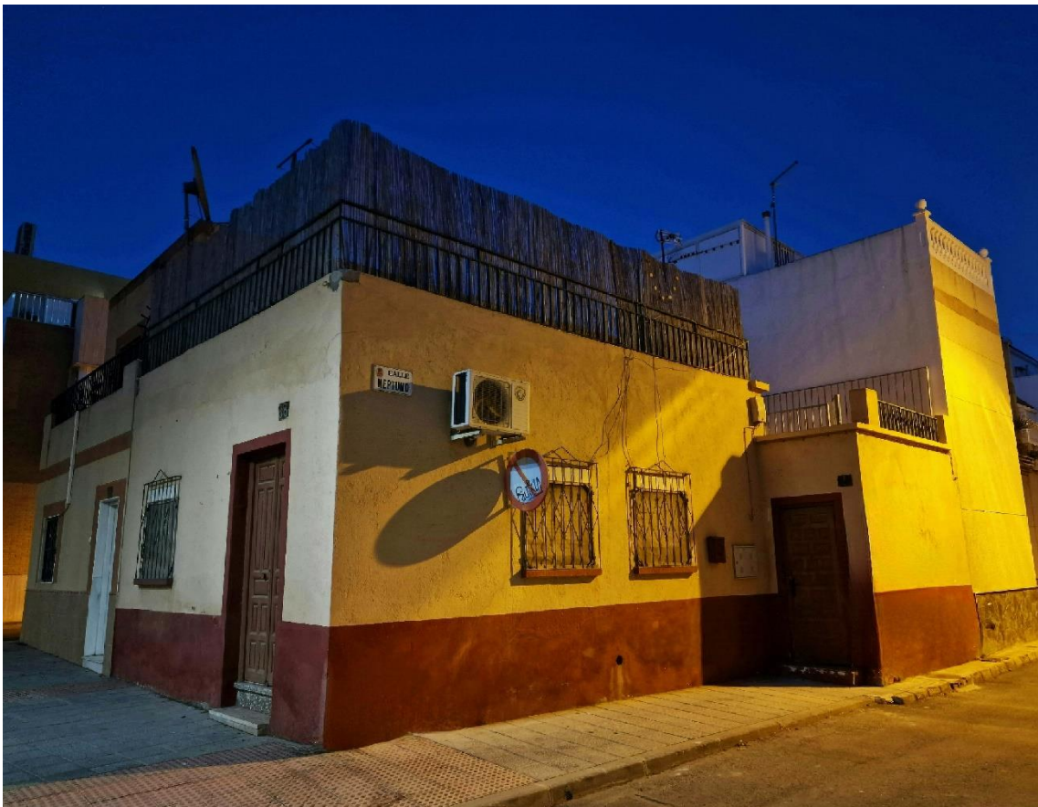
Fotografías 8.47 y 8.48: casa nº 1, de la Calle Neptuno. En sus fachadas, aunque modificadas, aún son reconocibles las tipologías edificatorias externas originales. Capturas del 3 de diciembre de 2022 y del 6 de agosto de 2023.
