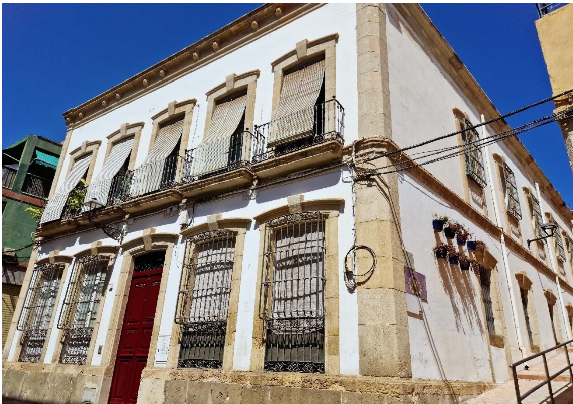
Fotografía 8.59: casona burguesa con tipología edificatoria externa del Mediterráneo más occidental, pero con algunos ornatos historicistas (denticulos seriados bajo la cornisa de la cubierta, cornisas sobre los arcos de puertas, ventanas y balcones, y cadenas pétreas esquineras). Calle La Almedina, nº 6 (entre las calles Clavel y Molino Cepero). Captura del 22 de agosto de 2023.
