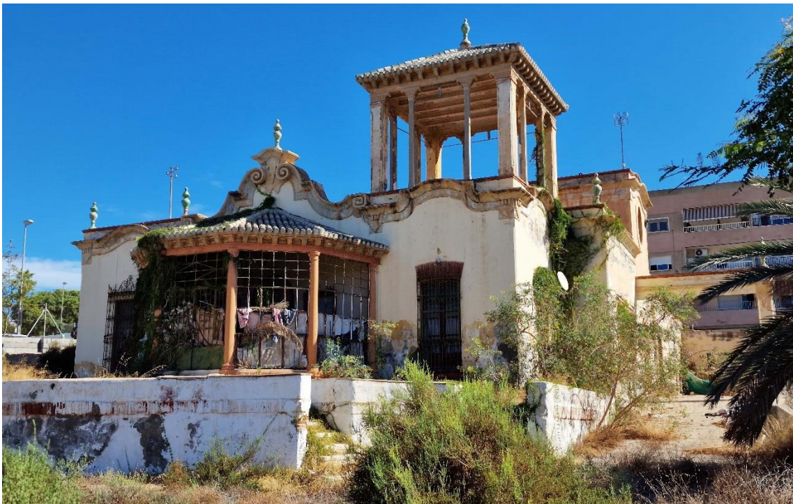
Fotografía 8.251: vista lateral de la vivienda principal del Cortijo de los Arcos-la Molineta, entre la calle Juan Cuadrado, la Avenida de la Cruz y la Calle Inglés. Se encuentra sumida en el abandono. El edificio fue levantado, a principios del siglo XX, por el arquitecto don Guillermo Langle Rubio. Destacan, en el conjunto de la construcción, un lucernario-mirador lateral, y una torre cubierta a cuatro aguas. Ambas piezas tienen cubiertas de tejas vidriadas y coloreadas. Captura del 19 de agosto de 2023.
