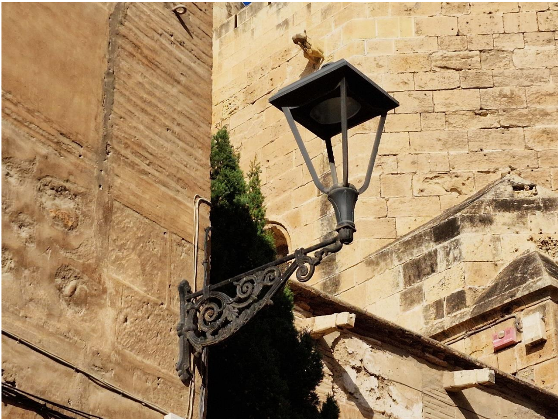
Fotografías 9.2 y 9.3: vista de la Calle Cubo, con sus luminarias de estilo clásico, adosadas a fachadas y a las caras externas de muros. Y observación de una de las luminarias en detalle. Capturas del 11 de diciembre de 2023.
