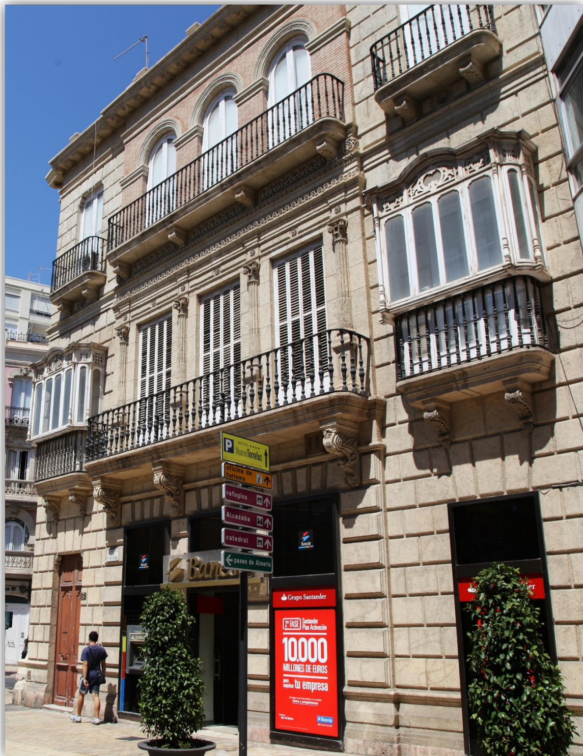
Fotografía 8.107: edificio historicista de la Puerta de Purchena, esquina con la Avenida de Pablo Iglesias, con sus miradores. Captura del 16 de agosto de 2013.
