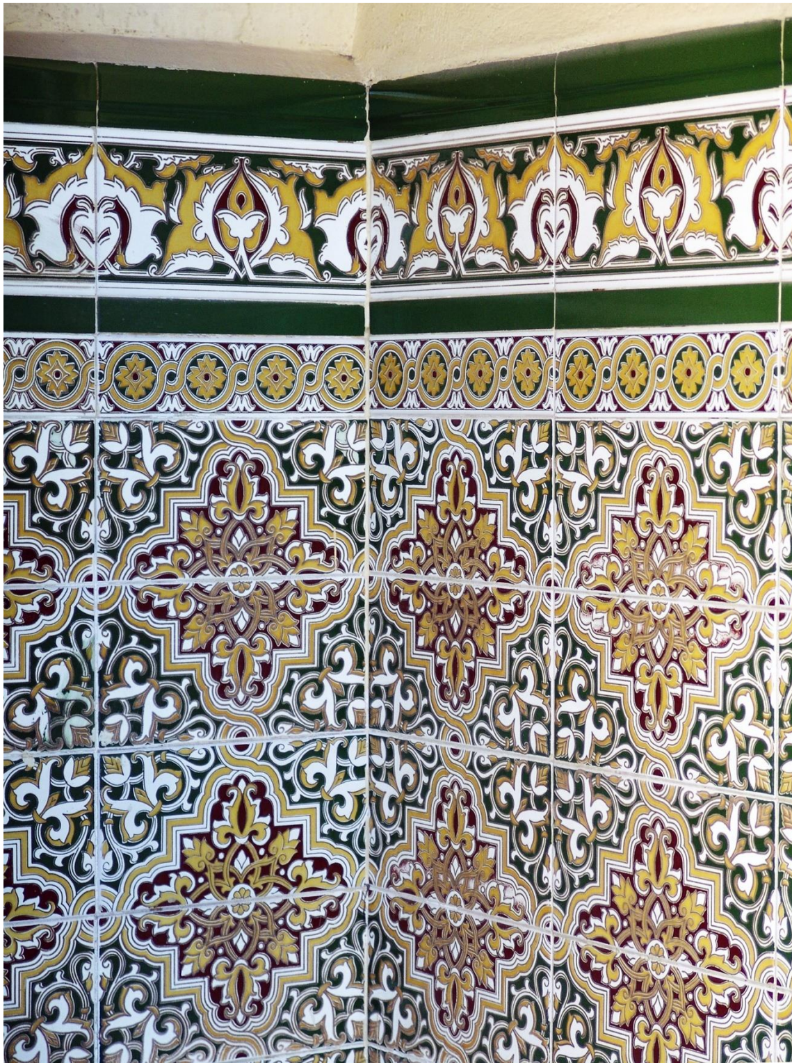
Fotografía 8.85: detalle de los azulejos (baldosas hidráulicas) del zaguán, que había, en su momento, en la casa nº 55 de la Calle Granada (Almería). Las losas hidráulicas, llamadas también mosaicos o azulejos hidráulicos, son piezas para cubrir suelos y/o paredes, tanto de interiores como de exteriores. Estas piezas son de cemento, con las superficies superiores adornadas con dibujos coloreados (con flores y/o figuras geométricas diversas). Se fabrican con el empleo de moldes, que tenían los compartimentos adecuados para formar los ornatos, a partir de agua, mármol blanco molido, arena y pigmentos. Una vez rellenados los compartimentos, los moldes se colmataban con una mezcla de cemento y arena. Mediante prensas hidráulicas, se fijaba la ornamentación colorista en la capa de cemento, sin que hubiera cocción. Durante el proceso de endurecimiento del cemento, y ya extraídas las baldosas de los moldes, sí se precisaba de rociados periódicos de agua. Las baldosas hidráulicas se utilizaron desde mediados del siglo XIX hasta la década de los años 60, del siglo XX. Captura del 31 de diciembre de 2007.
