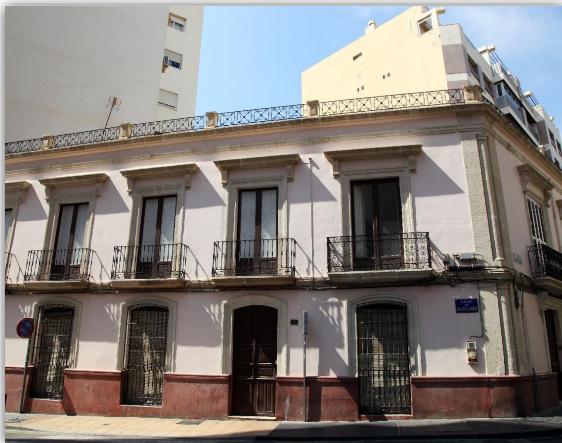
Fotografía 8.74: casa ubicada en la Calle de González Garbín, esquina con la Plaza de San Sebastián (Almería). Por una parte, y en las fachadas de la planta baja de la edificación, se encuentran las jambas y los arcos escarzanos en los vanos de puertas y ventanas, las rejas balconeras de las ventanas y el zócalo rojo de granito artificial que, junto con la cubierta en terrazo, son piezas arquitectónicas identitarias de la tipología edificatoria externa de las casas populares mediterráneas. Y, por otra parte, como piezas arquitectónicas de un Neoclásico, están las columnas cilíndricas esquineras (en este caso lisas) y, a modo de botaguas, las cornisas ornamentales, sostenidas por canecillos, de los balcones de un cuerpo, de toda la planta superior. Realmente, se trata de una casa de transición entre las de tipología popular mediterránea en Almería, para usuarios de economía media, y las historicistas para los usuarios de economía entre media y alta. Captura del 23 de agosto de 2018.
