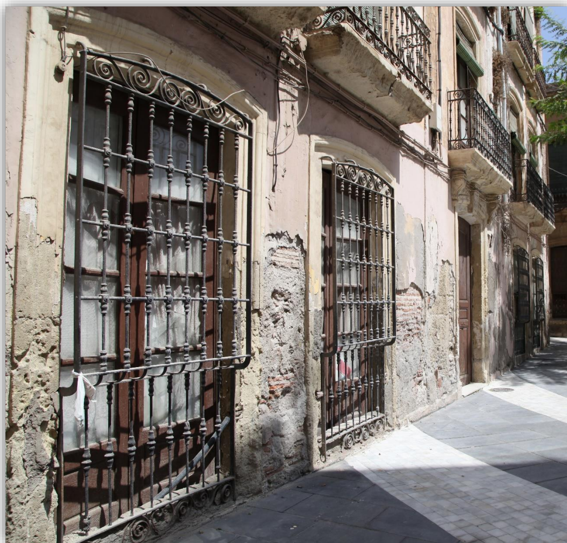
Fotografía 8.103: reja estándar en ventanas de un cuerpo, afincada en la tipología edificatoria historicista, con una notable impronta del estilo mediterránea almeriense. Plaza del General Castaños, nº 6. Captura del 28 de agosto de 2012.
