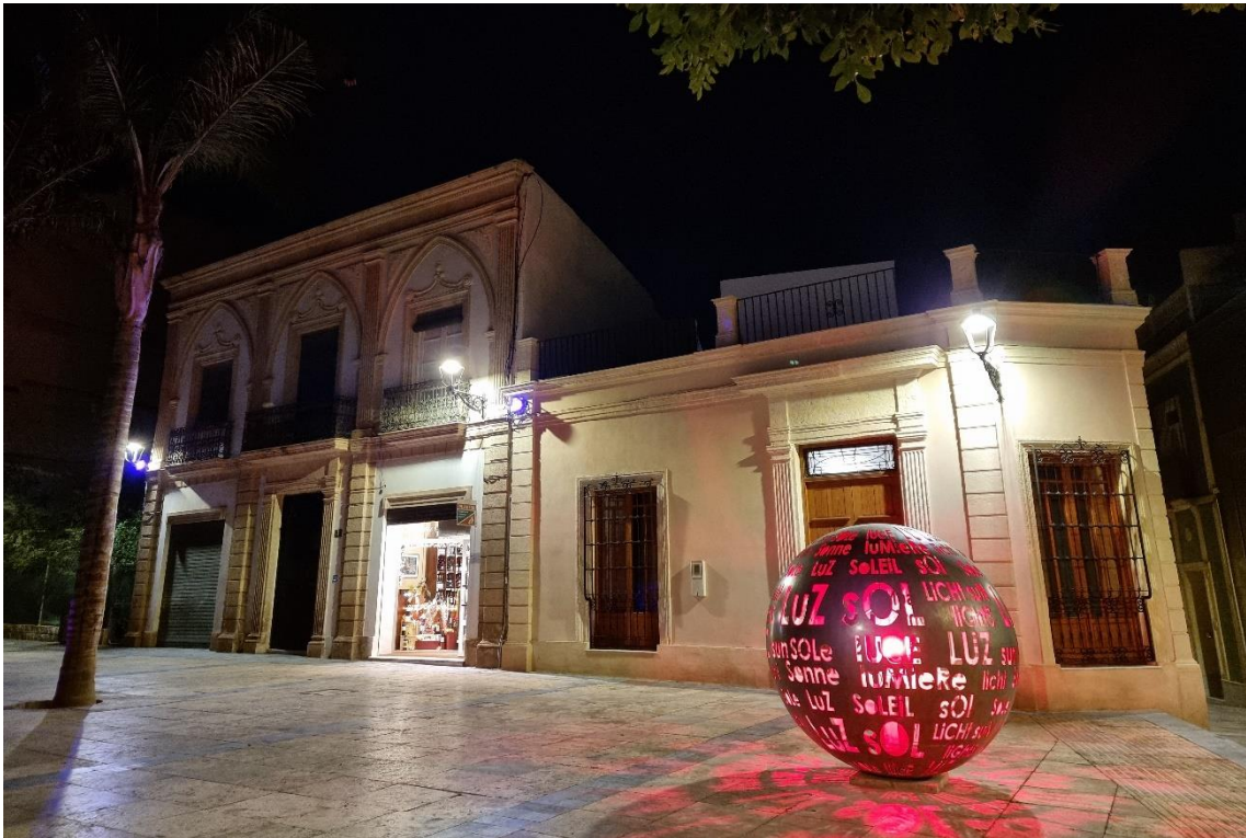
Fotografías 8.180 y 8.181: Palacio de los Marqueses de Torre Alta, ubicado en la Plaza Careaga. Según Del Pino (2016), concluyó su reedificación en 1847, por encargo de don Miguel Avis Venegas Granada Careaga. Tiene una tipología edificatoria historicista. Destacan los arcos apuntados del frontis. Capturas del 16 de agosto de 2013 (imagen superior) y del 1 de diciembre de 2022 (imagen inferior).
