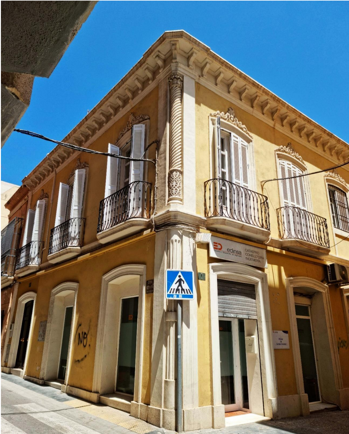
Fotografía 8.109: casa historicista en la Calle Regocijos, 22. Destaca la columna esquinera en tornillo, muy propia de la arquitectura historicista almeriense. Captura del 28 de julio de 2022.
