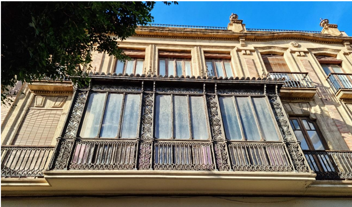
Fotografías 8.268 y 8.269: edificio originalmente habitacional, de estilo historicista, con un emblemático mirador modernista de hierro, presumiblemente forjado, rematado por un alero de teja vidriada. La disposición asimétrica de la puerta es otro rasgo modernista del edificio. Fue construido por el arquitecto don Guillermo Langle Rubio, en 1929, para don Vicente Batlles. El Paseo nº 118. Capturas del 10 de diciembre de 2022.
