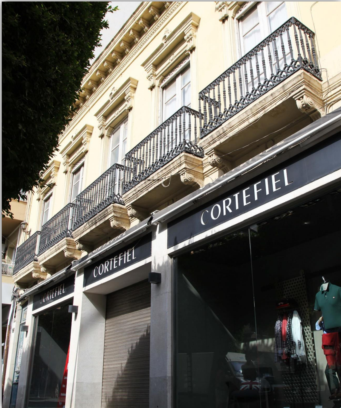
Fotografía 8.122: edificio historicista en El Paseo, n° 27. Destacan los balcones con barandilla de hierro, las cornisas sobre los dinteles de los balcones, la cornisa en la base del pretil y los canchillos que sostienen, aparentemente, a los suelos voladizos de los balcones, y a las diferentes cornisas. En las barandillas de hierro, los barrotes son esbeltos, y tienen, en sus secciones centrales, sucesiones de nudos (engrosamientos curvos), separados por estrechamientos. Captura del 27 de agosto de 2012.
