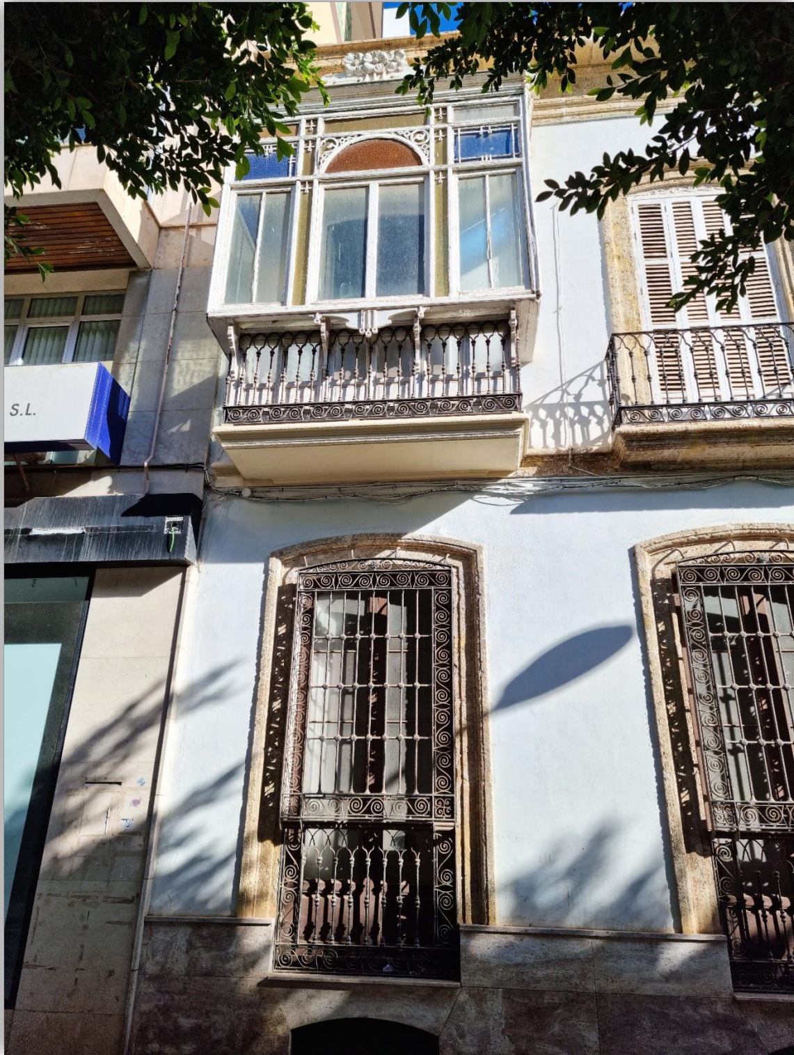
Fotografía 8.266: vista frontal de un edificio de El Paseo, nº 61, con una fuerte impronta del estilo mediterráneo almeriense, y con un mirador claramente modernista, por su acrótera floral y de otras filigranas decorativas, sugestivas y muy ricas en curvas que, según algunos, pueden hacer pensar en un rococó francés. El mirador, trabajado en madera, se halla cerrado por cristalerías coloreadas, y está construido sobre una base balconera ampliada. En el edificio, destacan también el herraje de las ventanas de un cuerpo, en la primera altura, y las barandillas de barrotes de los balcones. Estos herrajes tienen nudos como ornatos (centrales y en las terminaciones de los barrotes), aparte de las cenefas superior e inferior, y de las franjas laterales, con sus dobles espirales de giros opuestos. Captura del 2 de diciembre de 2022.
