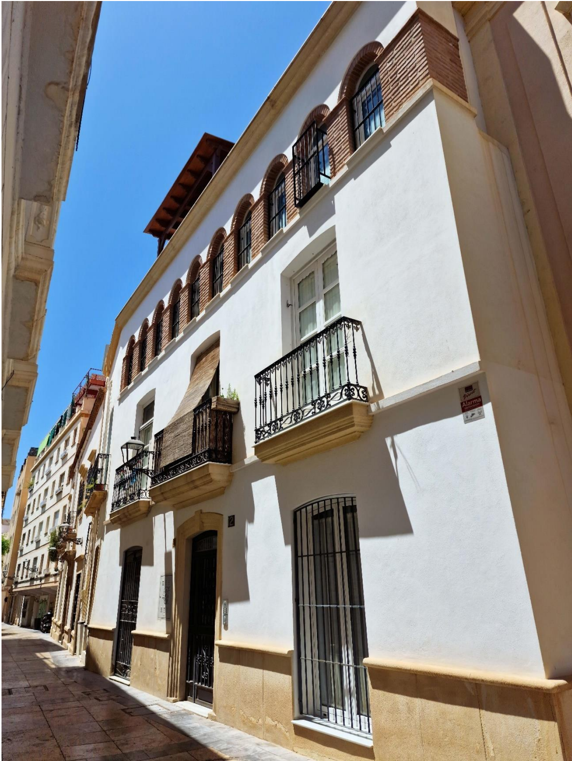
Fotografía 8.237: influencia mudéjar (arcos y columnas contruidos con ladrillos rojos de arcilla a la vista) en la última altura de una casa ecléctica, en donde hay improntas de los estilos mediterráneos e historicistas. En la última restauración, y después de eliminar encalados que ocultaban la realidad original, se utilizaron auténticos ladrillos árabes. Se quiso evitar una desnaturalización arquitectónica. Calle Emilio Ferrera, número 12. Captura del 28 de julio de 2023.
