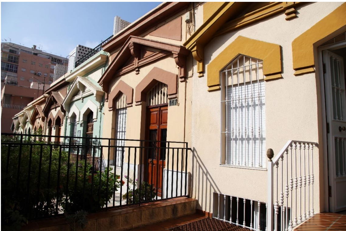
Fotografía 8.26: casas obreras del Malecón de los Jardincillos, en el margen derecho (aguas abajo) de la Rambla de Belén, justo antes de su confluencia con la Rambla de Amatisteros, para dar lugar a la actual Avenida Federico García Lorca. Captura del 28 de agosto de 2012.
