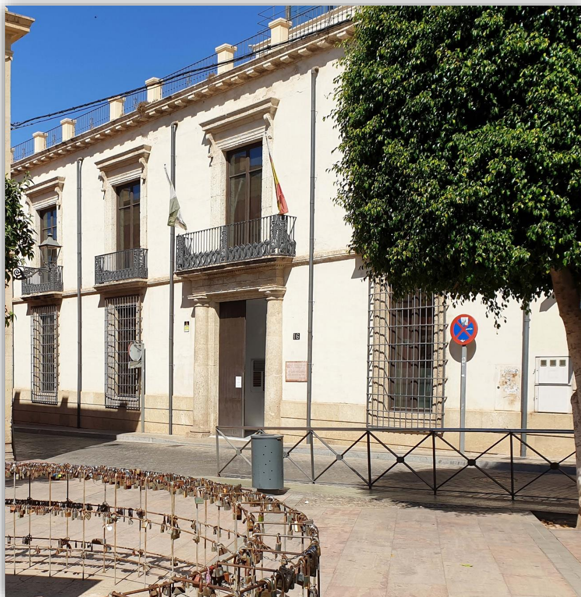
Fotografía 8.179: Palacio de los Marqueses de Cabra, ubicado en la Calle Arráez, esquina con la Calle de la Reina, visto desde la Plaza Campoamor. El edificio se construyó en 1840, por encargo de don José Jover. Las obras de restauración fueron encargadas al arquitecto don Nicolás Cermeño. Se iniciaron en 1990 y concluyeron en 2004. Tiene una tipología edificatoria neoclásica. Captura del 23 de agosto de 2019.
