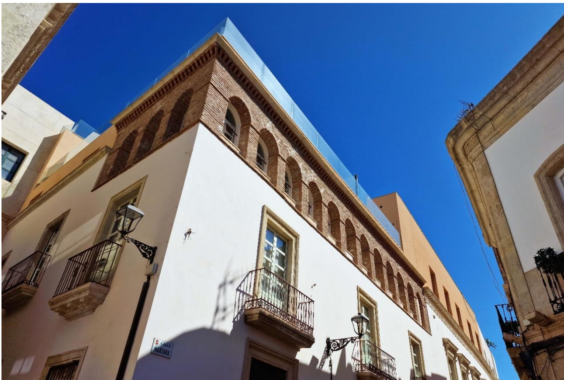
Fotografía 8.239: influencia mudéjar (arcos y columnas construidos con ladrillos rojos de arcilla a la vista) en la última altura de un edificio con tipología externa historicista. Calle Mariana, muy cerca de la Plaza de la Administración Vieja. Captura del 28 de julio de 2023.
