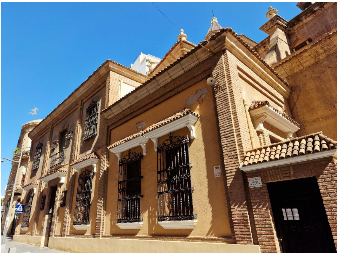
Fotografía 8.242: casa parroquial de la Iglesia de San Sebastián. Destacan las decoraciones con ladrillos rojos de arcilla a la vista, y las ventanas de un cuerpo con botaguas y ménsulas (en la planta baja). Captura del 13 de agosto de 2023.
