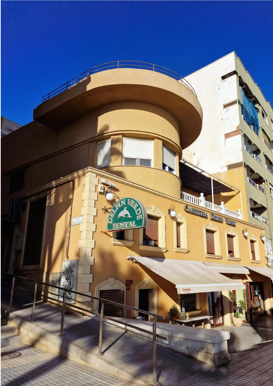
Fotografía 8.274: Hostal Delfín Verde, en el entorno del Paseo Marítimo de Almería, a la altura de la Playa de El Zapillo. El edificio tiene una tipología edificatoria externa del Modernismo, o con una fuerte incidencia de este estilo arquitectónico. Se trata de una antigua villa de tres alturas. John Lennon (colíder y fundador del grupo musical The Beatles) residió en este edificio, durante unas pocas semanas del año 1966. Desde aquí, Lennon se trasladó a la Finca Santa Isabel (hoy Casa del Cine), para continuar su estancia en la Ciudad de Almería. Captura del 16 de agosto de 2023.
