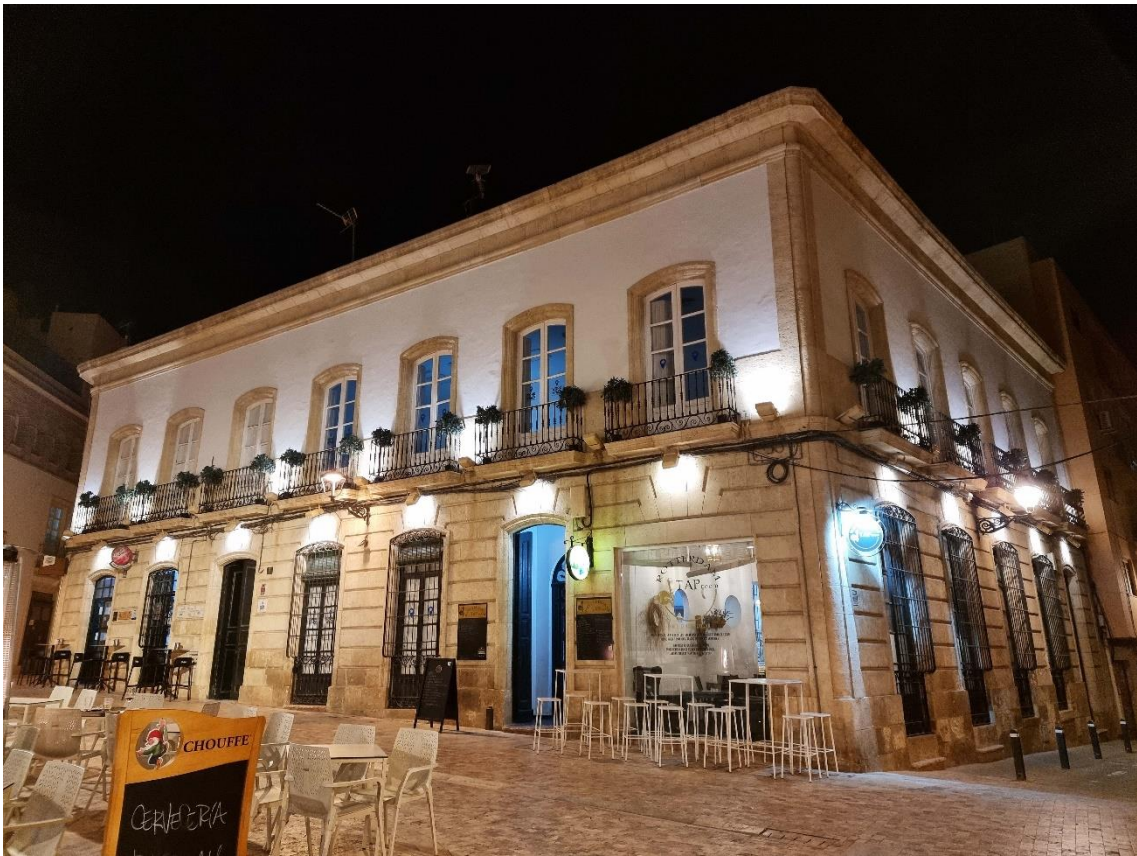
Fotografías 8.68 y 8.69: casona, originariamente habitacional, construida en 1890, con una tipología edificatoria externa propia de una casa burguesa de estilo popular del Mediterráneo más occidental. Está restaurada, habilitada y rehabilitada. En este edificio, ya se aprecia una cierta presencia de elementos arquitectónicos externos, como el almohadillado y las cadenas pétreas esquineras, utilizados en construcciones bajo la influencia de la cultura clásica grecorromana. Según Ravassa (2022), en sus bajos, hay un bar, inaugurado en 1963 (23 de diciembre), por don Diego García Cazorla. Por este bar, pasaron artistas como Enrique Morente y su hija Estrella. En 2008, don Ramón Belmonte, su esposa Mari Carmen Hermoso Hernández y sus hijos se convirtieron en los empresarios plenos del negocio. La Asociación de Vecinos del Casco Histórico premió a este bar, en 2021 (24 de enero), por su contribución a la hostelería almeriense. Plaza de la Administración Vieja, nº 1. Capturas, de arriba abajo, del 30 de noviembre de 2022 y del 1 de diciembre de 2022.
