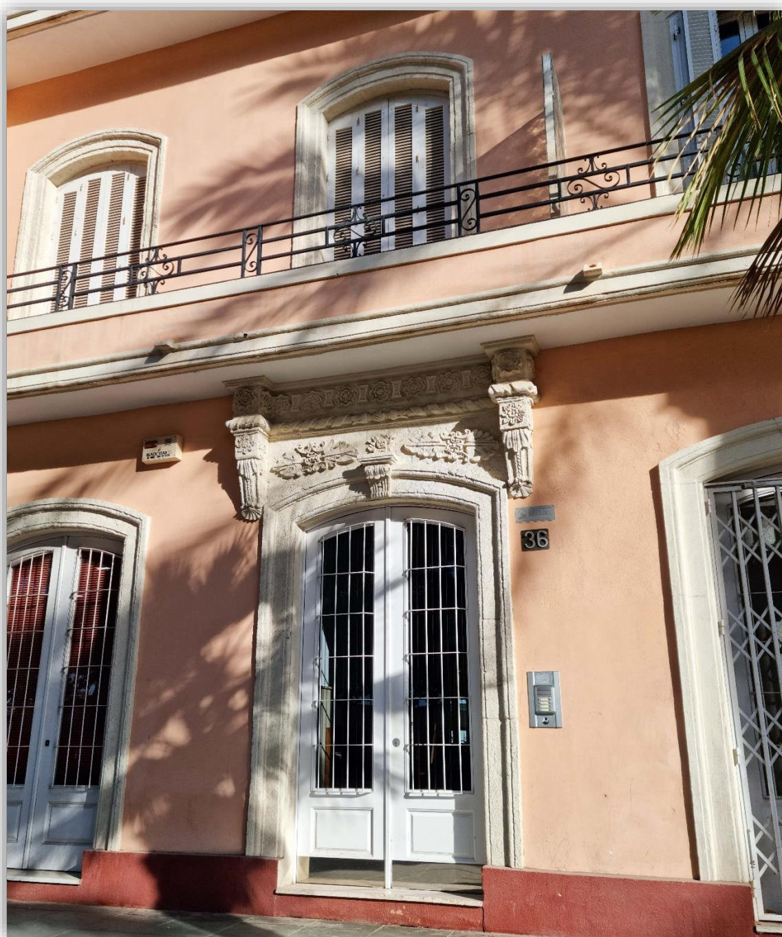
Fotografía 8.271: edificio en el Parque de Nicolás Salmerón, números 36, 38 y 40, entre las calles Alborán y Santa Cruz. Su interior fue reedificado en 1991. Detalles de los ornatos y decoraciones modernistas, a modo de un sombrerete sobre el arco escarzano, en una de las tres puertas de acceso. Los ornatos del sombrerete conforman una clave en el propio arco escarzano, un arquitrabe sostenido por el arco escarzano, un friso con gruesos bordes y con resaltes laterales de sección rectangular, y unas columnas abortadas (suspendidas). Los supuestos sustentantes del friso son el arquitrabe y las columnas abortadas. Estas columnas tienen cortos fustes rectangulares, capiteles de secciones rectangulares y prolongadas basas en chorreras piramidales, que acaban en aparentes semi flores abiertas y cortadas en planta. El desarrollo de las columnas sólo llega a los extremos del arco escarzano, casi yuxtapuestas a los extremos externos superiores de las jambas. Todos estos elementos ornamentales llevan una decoración recargada, a modo de un encaje más o menos tupido, formada, principalmente, por motivos florales en sentido lato, que incluye tallos y hojas. El conjunto de la decoración se acerca a un rococó francés. Las otras dos puertas presentan ornatos y decoraciones semejantes. Captura del 30 de noviembre de 2022.
