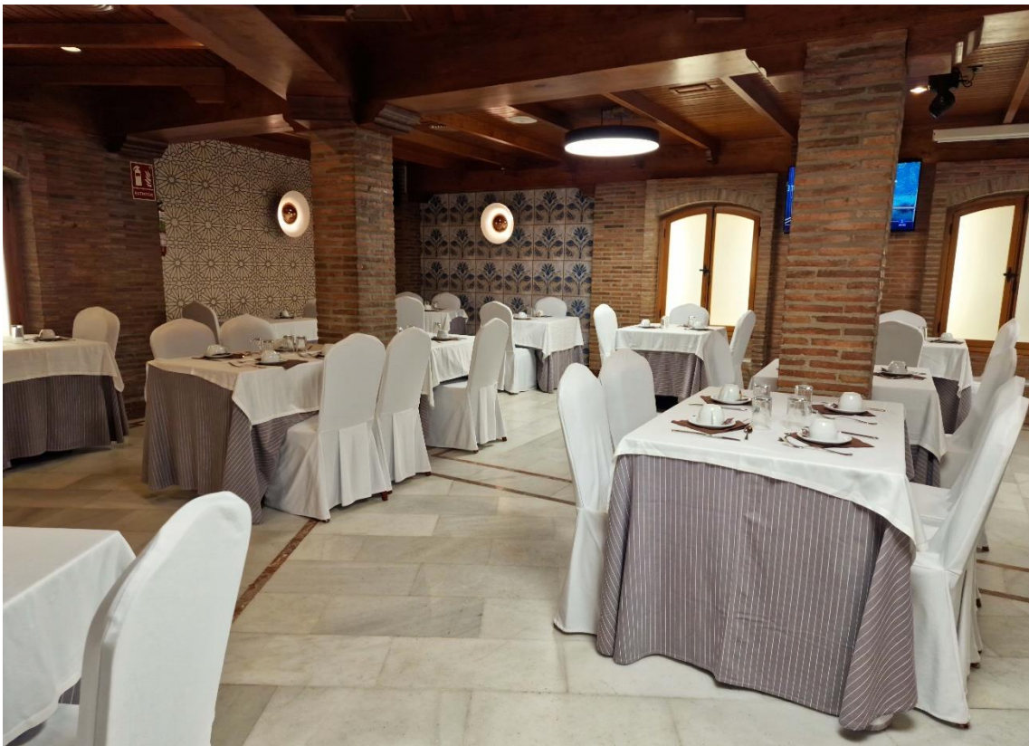
Fotografías 8.232 y 8.233: Hotel Nuevo Torreluz, en la Plaza Flores. En algunas dependencias, el interiorismo está inspirado en la cultura mudéjar. Destaca la lacería en cerámica de algunas paredes, la utilización del ladrillo de arcilla a la vista, y el techo de tablas yuxtapuestas sobre vigas de madera. Capturas del 26 y del 28 de julio de 2023 (de arriba abajo).
