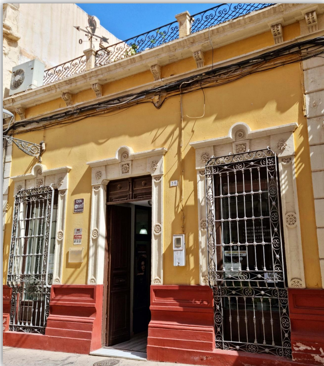
Fotografía 8.73: casa ubicada en la Calle La Almedina, nº 50. Sobre una base de la tipología edificatoria externa de las casas populares mediterráneas almerienses, con sus ventanas de un cuerpo cerradas por rejas balconeras, con un zócalo rojo que emula al granito artificial, y con una cubierta en terrao , hay ornatos propios de una tipología edificatoria historicista, sobre los dinteles y en las jambas. Los dinteles de las puertas y ventanas dan apoyos a frisos horizontales con bajorrelieves, rematados por viseras, a modo de cornisas. Estas viseras soportan, a su vez, reducidas formas en posiciones centrales, que hacen recordar a pequeños frontones circulares. Las jambas están acanaladas y encierran bajorrelieves. La casa desarrolla una fachada con una tipología edificatoria que, en su conjunto, sería una clara transición entre los estilos de una casa popular mediterránea en Almería (para usuarios de economía baja-modesta) y de una casa historicista (para usuarios de economía media). Captura del 23 de julio de 2022.
