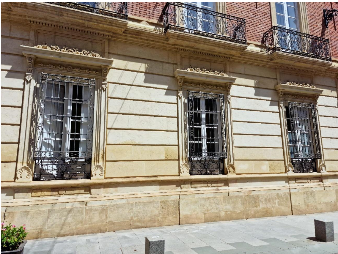
Fotografías 8.190 y 8.191: algunos detalles ornamentales del palacete historicista de don Juan Lirola, en la Calle Navarro Rodrigo, nº 17, esquina con la Calle Reyes Católicos. El edificio fue construido en 1884, por el arquitecto don Trinidad Cuartara Cassinello. Capturas del 6 de agosto de 2013 (imagen superior) y del 27 de julio de 2023 (imagen inferior).
