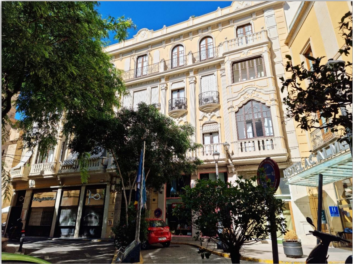
Fotografía 8.141: Casa de los Roche, ubicada en la Plaza Flores (antigua Plaza de Canalejas). Tiene una tipología edificatoria externa historicista. Se trata de un edificio de viviendas plurifamiliares. Destacan los miradores y las repisas aveneradas de los balcones en púlpito , con barandillas semicilíndricas de herraje, entre otros elementos arquitectónicos. Fue construido por el arquitecto don Guillermo Langle Rubio, en 1924, por encargo de don Facundo Sebastián Roche (comerciante y concejal). En esta construcción, se utilizaron, por primera vez en la Ciudad de Almería, pilares de hormigón armado y vigas metálicas en los techos. El señor Langle, cuando quedó viudo, ocupó una de las viviendas del edificio, según Ravassa (2022). Captura del 15 de agosto de 2022.
