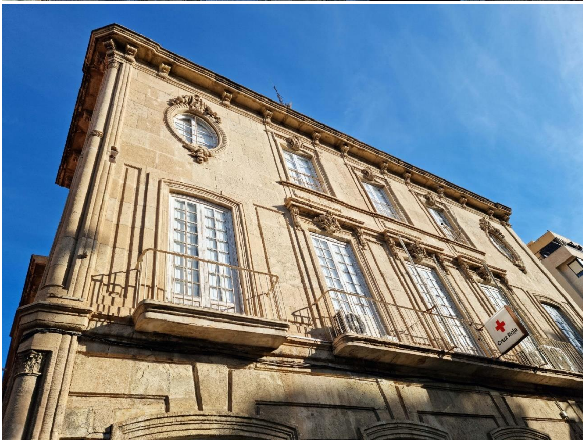
Fotografías 8.125 y 8.126: edificio de la vivienda de don Fernando Roda González (industrial, comerciante y primer presidente de la Junta del Puerto de Almería). En la actualidad, el edificio está ocupado por la sede de la Cruz Roja en Almería Se encuentra en el Paseo de San Luís, nº 28. Fue construido en 1864, de acuerdo con el proyecto del arquitecto don José Marín Baldó. Presenta una tipología edificatoria externa historicista. Capturas del 30 de noviembre de 2022.
