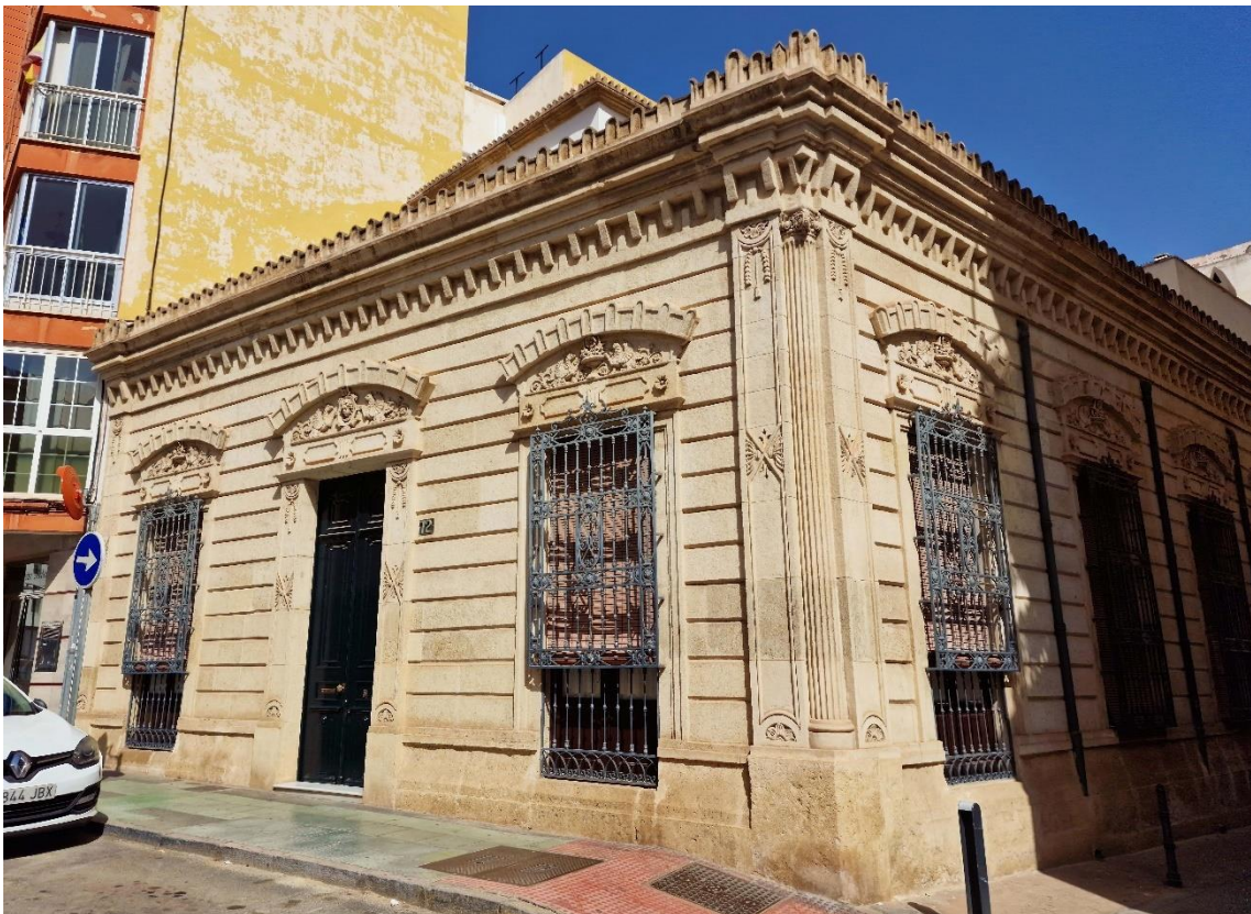
Fotografía 8.260: casa nº 72 de la Calle Granada, proyectada por don Enrique López Rull. Se percibe una tipología edificatoria externa modernista, por la combinación imaginativa de diferentes estilos. Se mantienen las improntas de las casas de puerta y ventana (con fachadas amplias), y de las columnas esquineras. Destaca una densa balastrada de coronación y una ornamentación cargada, entre los dinteles y los arcos escarzanos. En el interior, el modernismo se encuentra definido por una ornamentación floral. Captura del 30 de julio de 2023.
