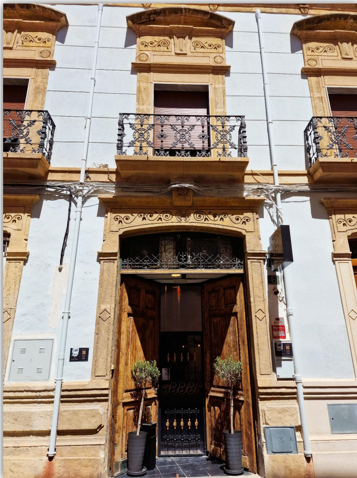
Fotografía 8.99: detalle de la Casa nº 4 de la Calle Méndez (transversal a la Calle Granada). El edificio tiene un estilo historicista. Llama la atención la presencia desubicada de las claves simuladas (sólo son ornamentales), en relación con las colocaciones de claves que hubieran tenido funcionalidad estructural. Captura del 6 de agosto de 2023.
