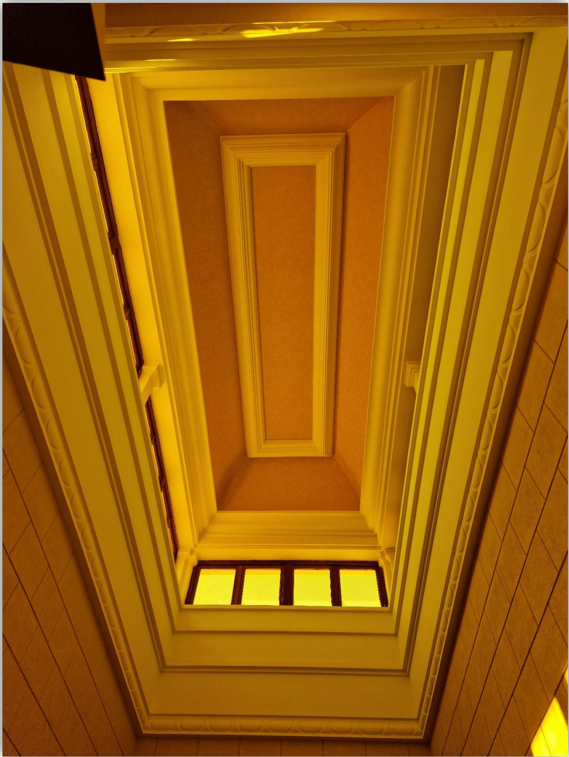
Fotografía 8.248: vista del techo principal en artesa invertida, construido de obra. del Cortijo Balmás (Casa del Cine). Captura del 17 de agosto de 2023.
