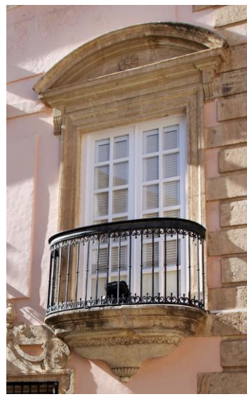
Uno de los balcones secundarios con frontones redondeados y armados, y sobre ménsulas aveneradas (en lugar de canecillos).
