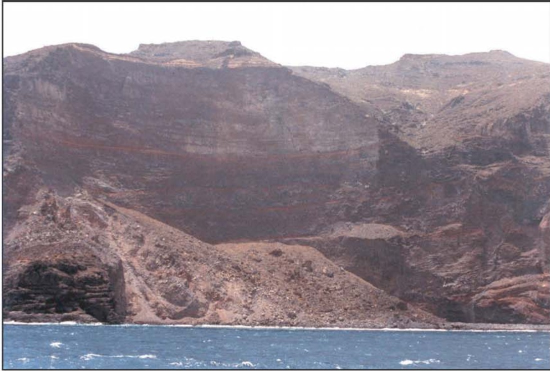
Photo 2.40 - La cicatrice de l'effondrement de Cuevas Blancas, en 1949 (côte nord de La Gomera). De telles cicatrices sont fréquentes sur les falaises des édifices anciens (Teno, Anaga, Gran Canaria). Ce sont des petites déstabilisations qui, bien qu'instantanées, s'inscrivent dans un processus de destruction sur le long-terme.
