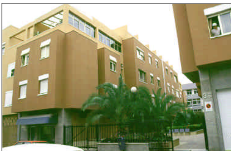
Figura IX. 15. Promoción realizada por Edificio Santa Catalina en el barrio del mismo nombre (Id. 189)
