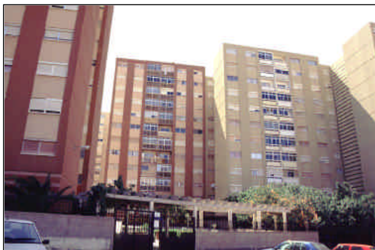
Figura IX.26. Edificio realizado por HUARTE en La Feria (Id. 188)
