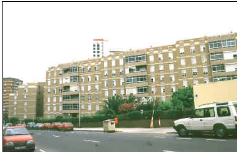
Figura IX.12. Urbanización realizada por Promociones y Contratas del Río en Buenavista (Id. 329)
