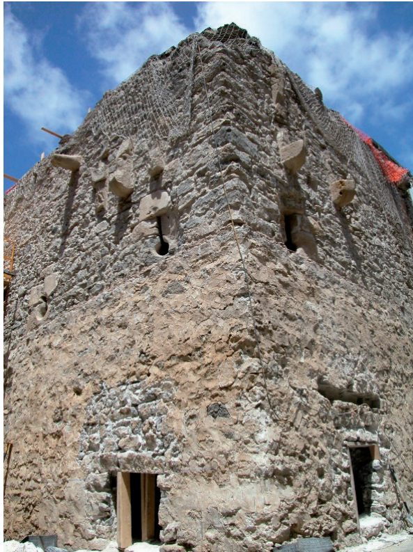
Figura 7. Vista de la torre de Las Isletas durante los trabajos de excavación de 2001-2002. Foto: Julio Cuenca Sanabria y José Guillén Medina. Archivo: PROPAC S.L.
