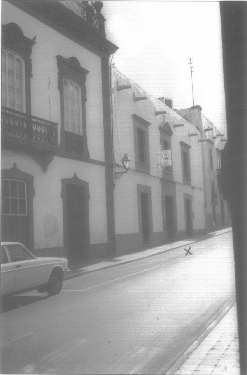
2. Con una (X) se indica el edificio de la calle Castillo donde estuvo la Escuela Normal en dos ocasiones (el n° 11 actual corresponde al antiguo n° 13).
