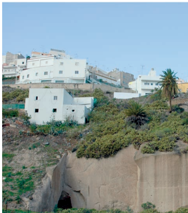
Fotos: 9 y 10. Edificaciones sobre toba volcánica "ash and pumice" en San Nicolás y edificaciones de autoconstrucción sobre taludes naturales carentes de medidas de contención, en Lomo Apolinario
