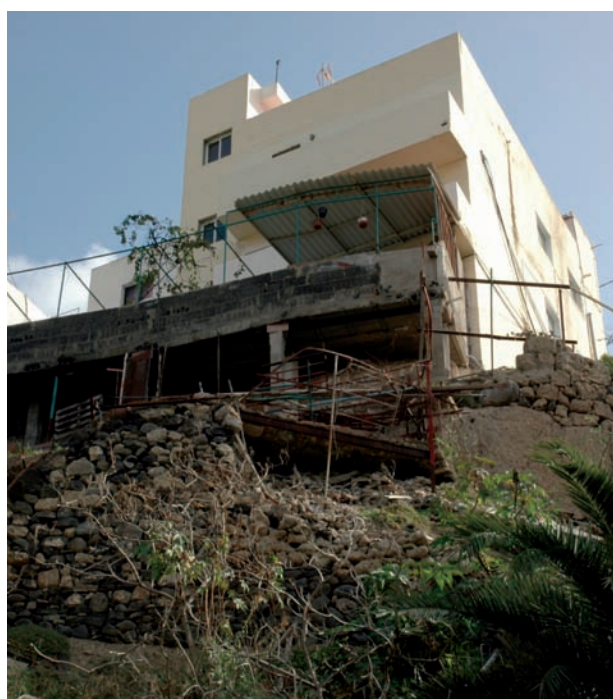
Fotos 5 y 6. Proceso erosivo activo con movimientos de tierras y piedras, con afectación de cimientos en edificaciones de San Roque y Casa Blanca III
