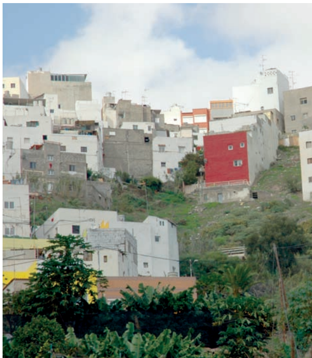
Fotos: 9 y 10. Edificaciones sobre toba volcánica "ash and pumice" en San Nicolás y edificaciones de autoconstrucción sobre taludes naturales carentes de medidas de contención, en Lomo Apolinario
