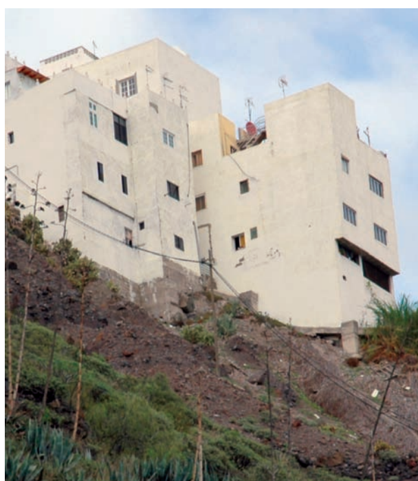
Fotos 5 y 6. Proceso erosivo activo con movimientos de tierras y piedras, con afectación de cimientos en edificaciones de San Roque y Casa Blanca III
