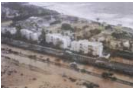
Figura 4. Estado de la carretera comarcal 812 tras las lluvias de noviembre de 2001. (Ayuntamiento de San Bartolomé de Tirajana)
