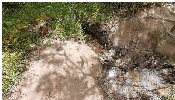
Fotografía 50. Sendero deteriorado por flujo de agua Liven Martinez - 2017
