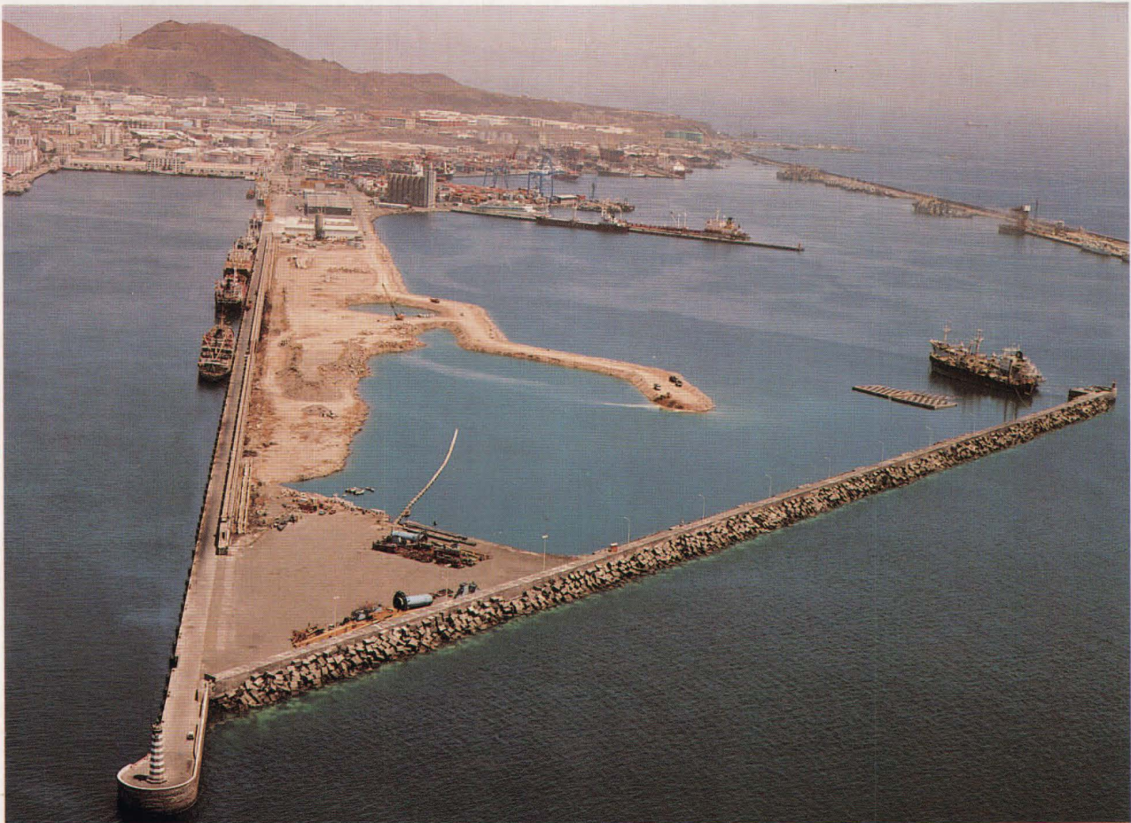
Vista aérea parcial del Puerto de La Luz (Las Palmas de Gran Canaria).
